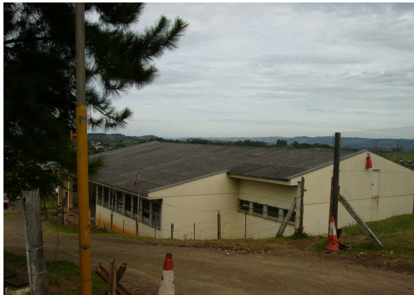
Figura 3 – Penitenciária de Taquara-RS - prédio do regime semi-aberto
