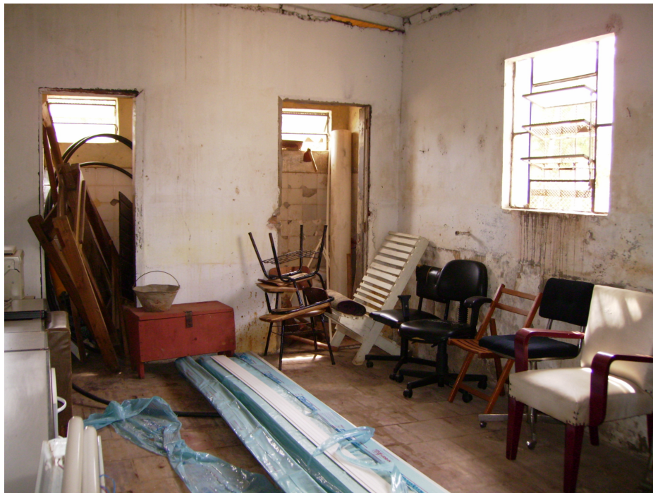
Figura 12- Área interna da futura instalação de atendimento à saúde
