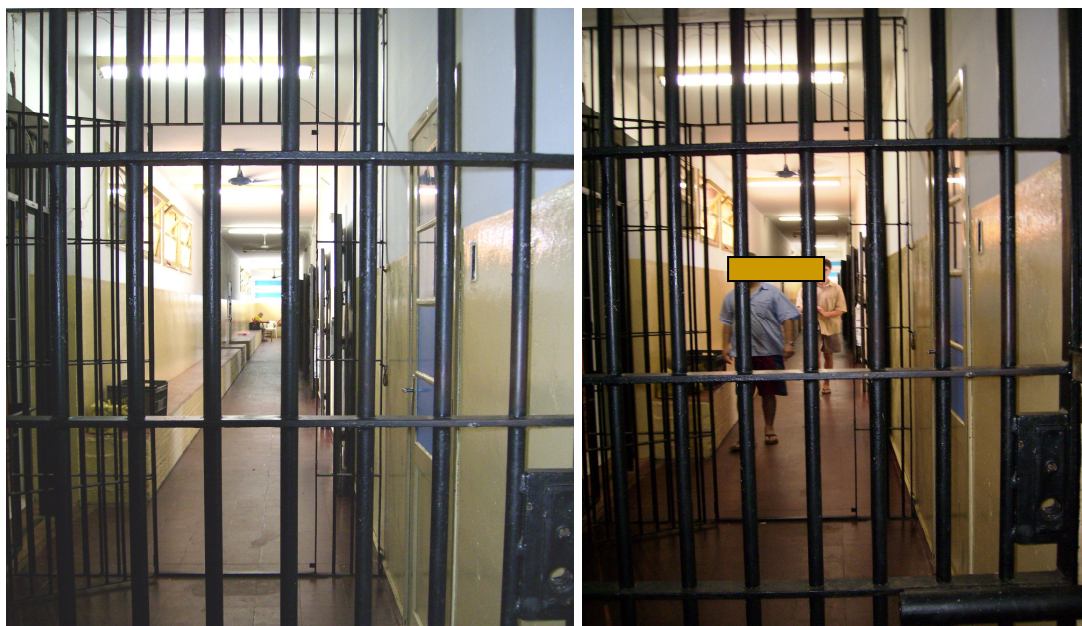
Figuras 14 e 15 – Galerias internas do presídio de Taquara-RS
