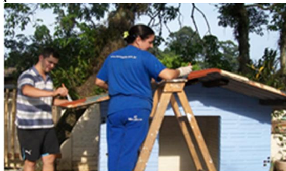
Familiars pintando o telhado
