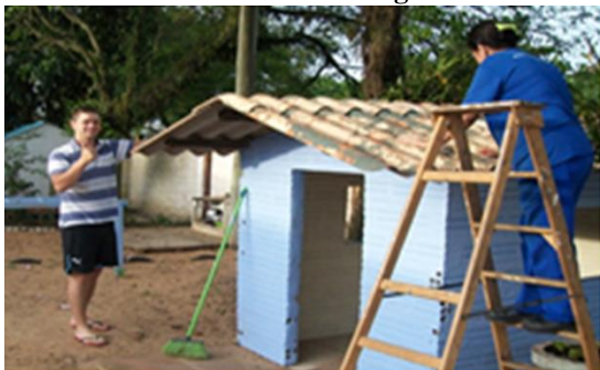
Familiars lixando e limpando o telhado
