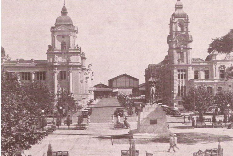
FIGURA 3 – AVENIDA SEPÚLVEDA, AO FUNDO O PORTO, COM AS TORRES DOS PRÉDIOS FORMANDO O PÓRTICO DA CIDADE.
