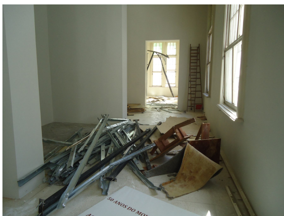
FIGURA 10- PROCESSO DE RETIRADA DA LINHA DO TEMPO: A ESQUERDA, ABAIXO DOS ENTULHOS, SE ENCONTRA O TESTEMUNHO DO PISO ORIGINAL DO COFRE DOS CORREIOS.
