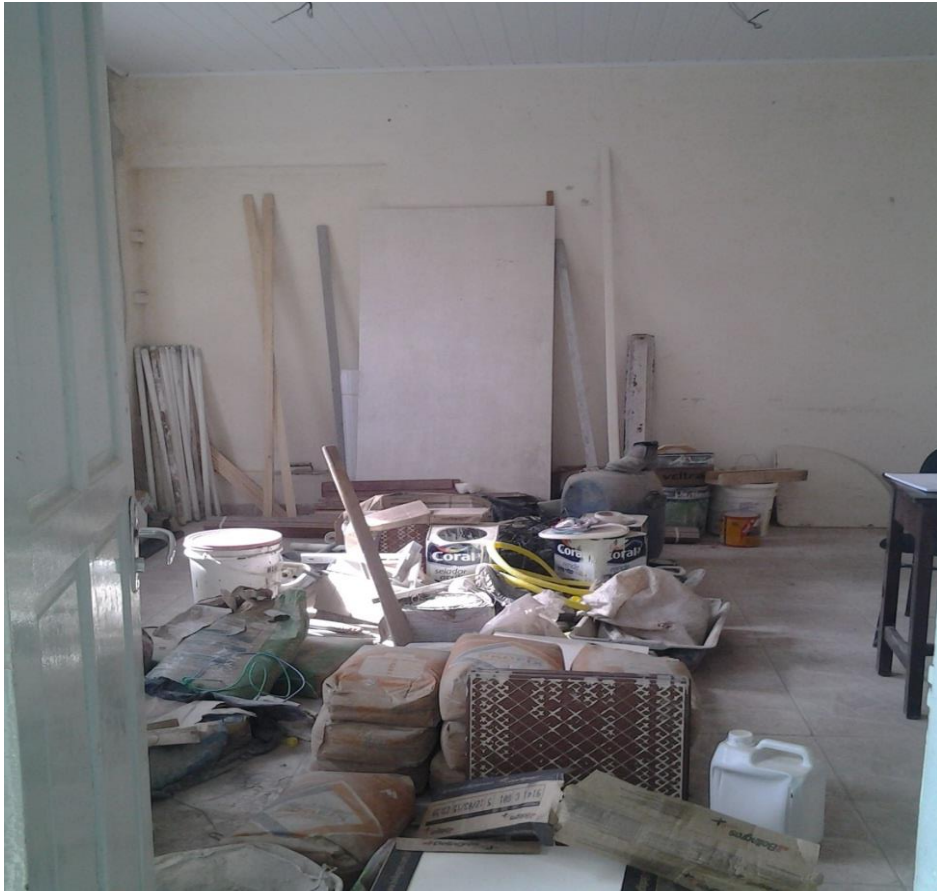
Figura 3 – Sala de aula servindo de depósito de materiais da reforma
