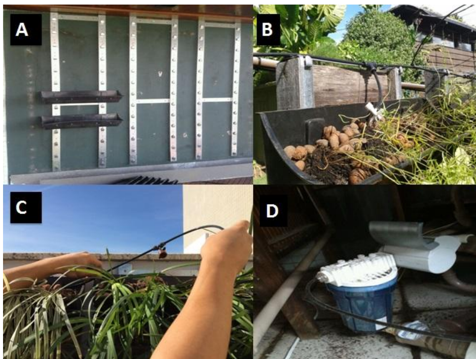
Figura 7 – Aspectos construtivos das paredes verdes executadas pela Empresa EcoTelhado, Porto Alegre, 2015. (A) Armação de alumínio para fixação das floreiras; (B) Interior da floreira e linhas de fertirrigação.; (C) Microaspersor (D) Sistema automático de fertirrigação. Fotos: Ricardo Rambor.
