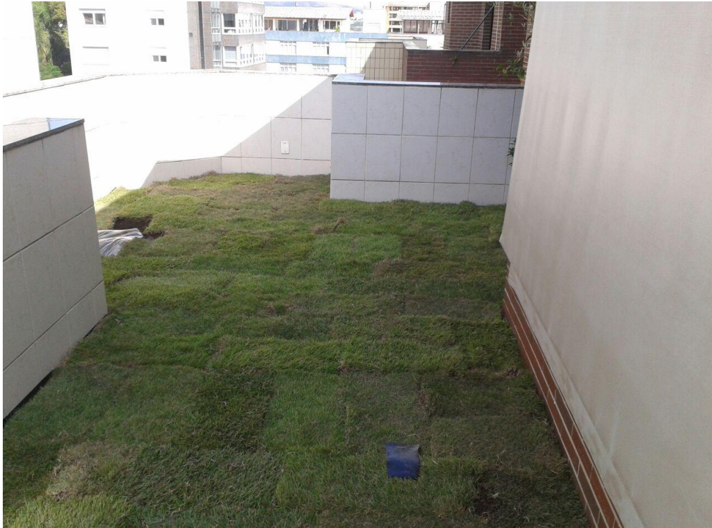
Figura 5 – Instalação de telhado verde tendo como cobertura leivas de grama esmeralda ( Zoisia japonica ).Ecotelhado, 2015.Foto: Ricardo Rambor
