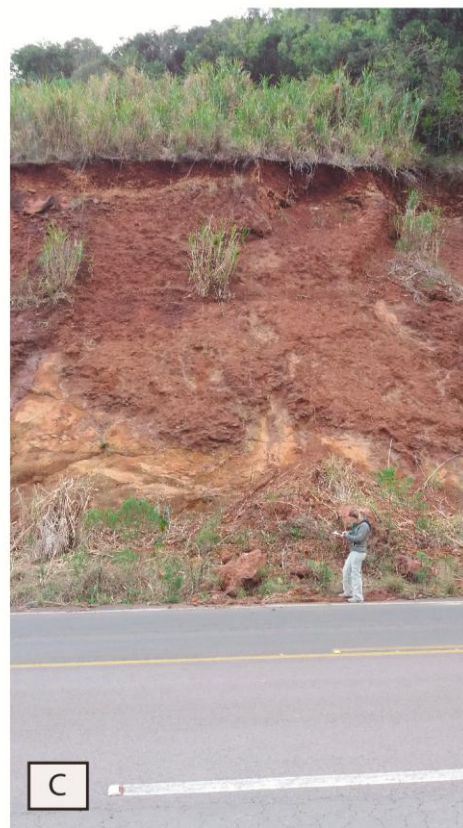
Figura 11: (A) e (B) blocos caídos da porção brechada; (C) porção do talude com intensa alteração
