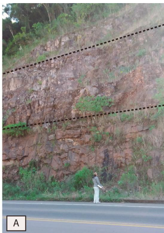
Figura 7: (A) visão do talude com 2 patamares colocados nas porções entre derrames (linha preta pontilhada); (B) bloco com diversas amígdalas caído
