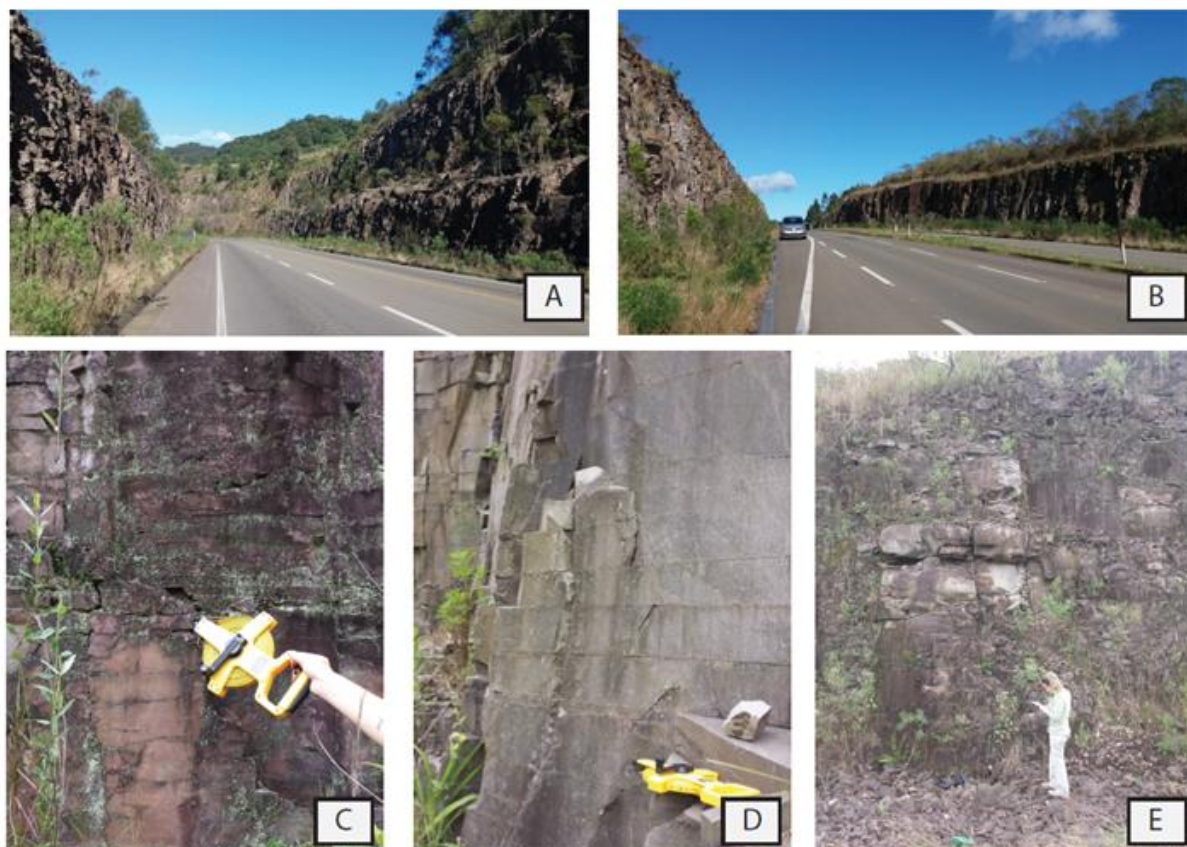
Figura 10 - (A) Imagem mostrando a grande continuidade lateral dos talude do segmento S18 (sentido norte); (B) Imagem mostrando a grande continuidade lateral dos talude do segmento S22 (sentido sul); (C) descontinuidades horizontais do talude direito do S18; (D) descontinuidades horizontais do talude direito do S20; (E) visão da altura do talude e das descontinuidades horizontais do S20
