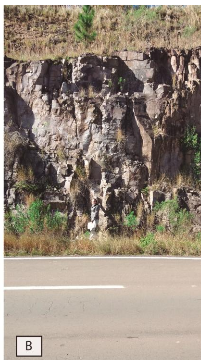
Figura 16: (A) visão dos dois taludes no sentido sul; (B) talude direito.
