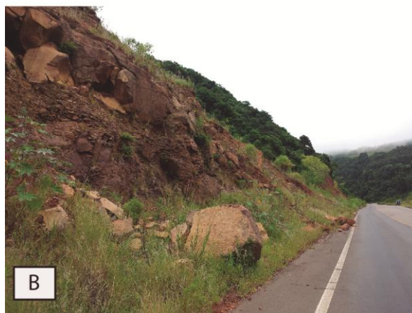
Figura 11: (A) e (B) blocos caídos da porção brechada; (C) porção do talude com intensa alteração
