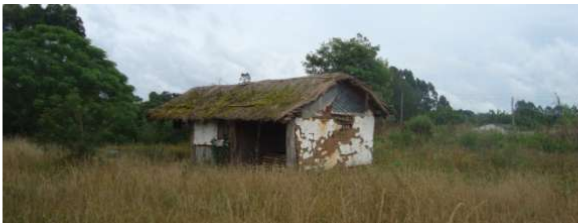
Imagem 15 - Rancho abandonado presente na comunidade quilombola Cerro das Velhas
