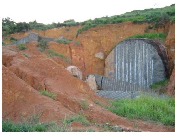
Figura 33- Lavra de matacão abandonada, onde a falta de manutenção gera áreas instáveis. Fonte: SGM
