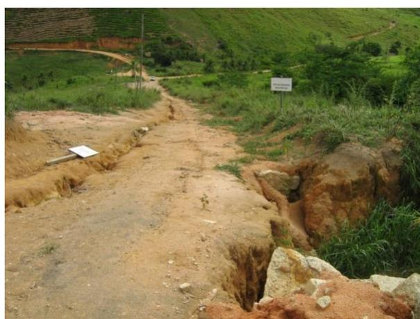
Figura 30 - Voçorocas formadas pelo abandono, bem como caixas secas inoperantes. Fonte: SGM
