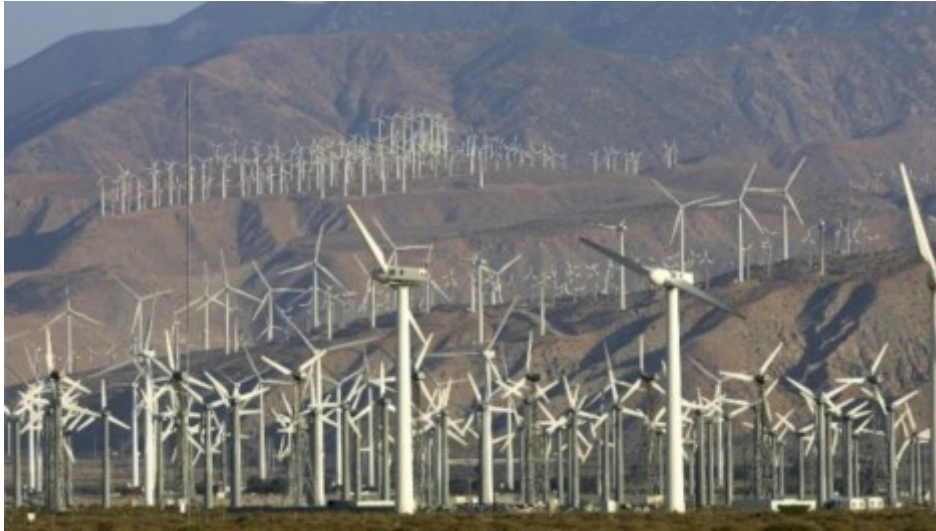
Figura 3.7- Parque eólico densamente ocupado em Palm Springs, California, EUA.
