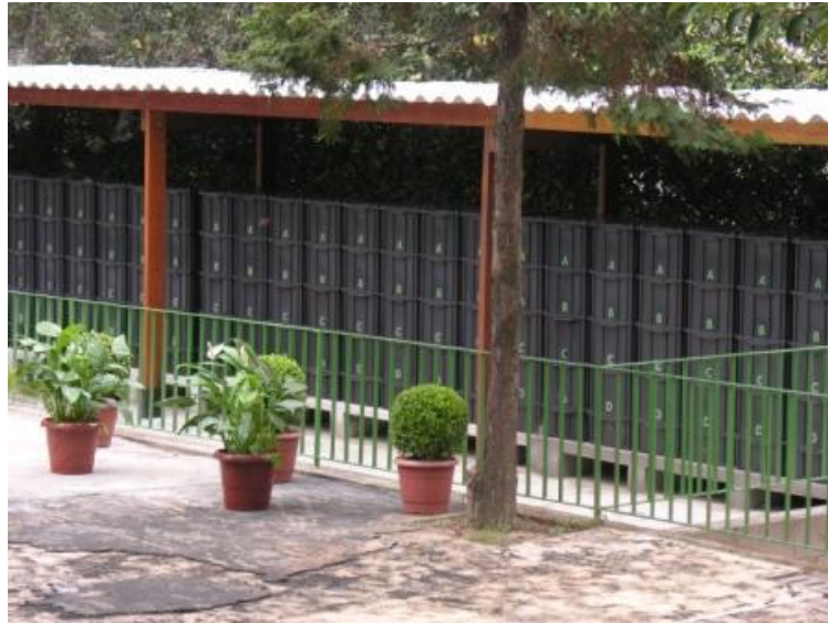
Figura 9 – Sistema de vermicompostagem doméstica para tratamento de resíduos orgânicos de grandes geradores
