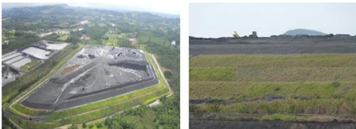
Figura 3. Vista superior e lateral das camadas de rejeitos de um módulo da Carbonífera Criciúma.
