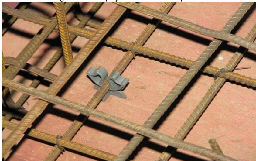
Figura 10 – Espaçador cavalete de plástico
