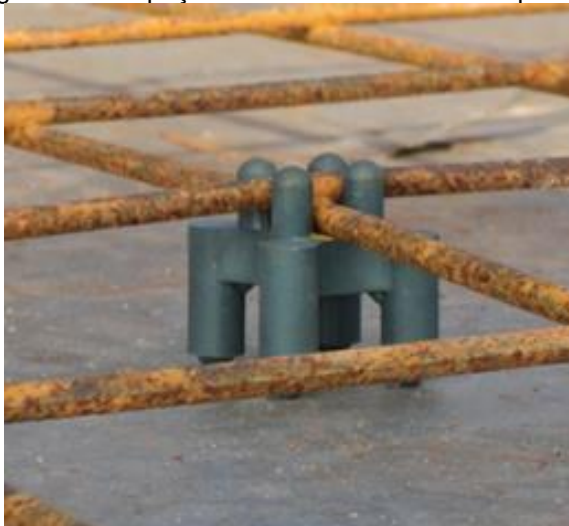
Figura 11 – Espaçador torre ou cadeirinha de plástico
