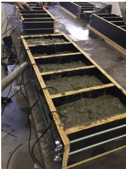
Figura 21 – Preenchimento das formas com concreto
