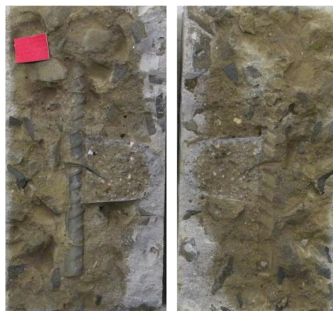
Prisma de Argamassa – 8 dias de ensaio – ciclos de calor
