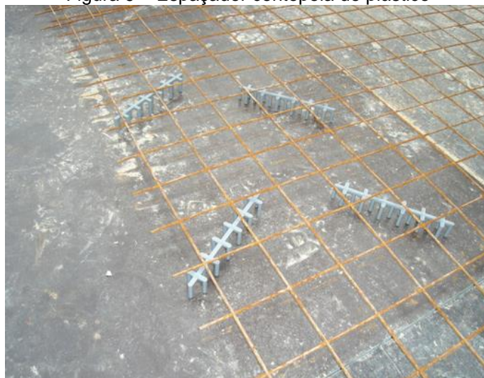
Figura 9 – Espaçador centopeia de plástico
