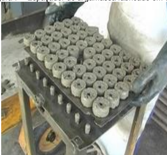
Figura 7 – Espaçador de argamassa fabricado em obra
