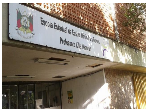
Fachada do prédio
