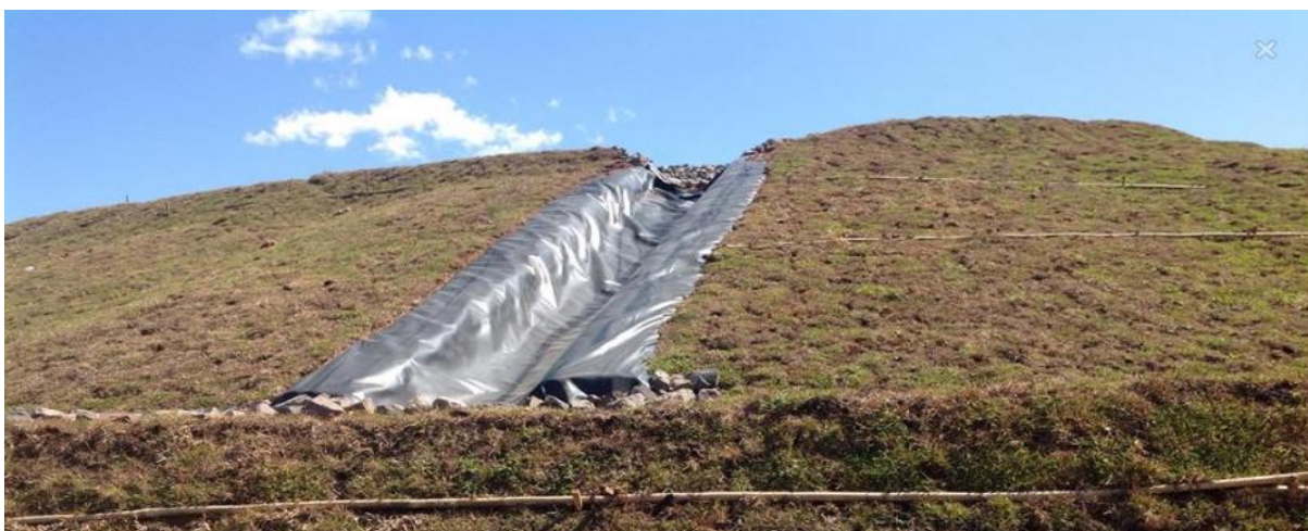
Figura 5.9 – Canal de drenagem de águas pluviais
