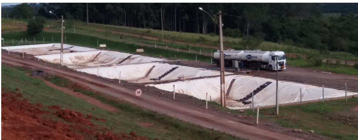
Figura 5.10 – Lagoa de acúmulo e equalização
