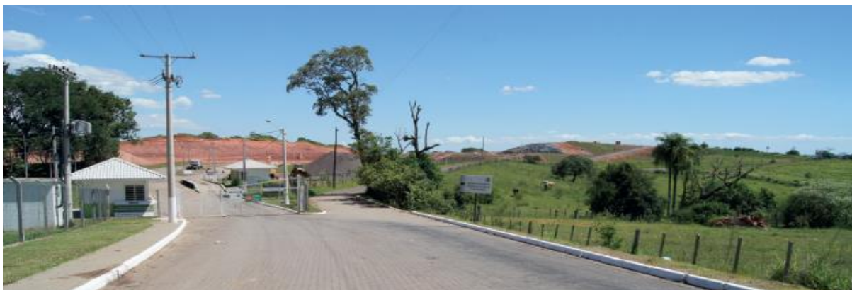
Figura 5.2 – Acesso principal do aterro sanitário
