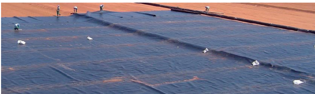
Figura 5.6 – Instalação da geomembrana de PEAD
