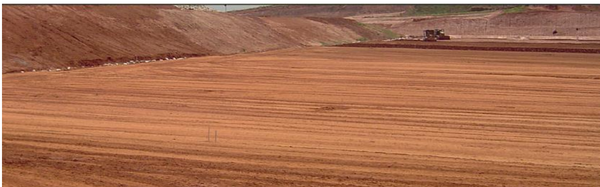
Figura 5.4 – Preparação da base do aterro
