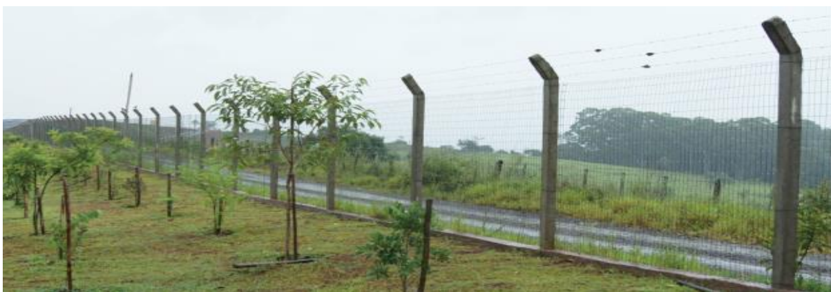
Figura 5.3 – Acesso principal do aterro sanitário
