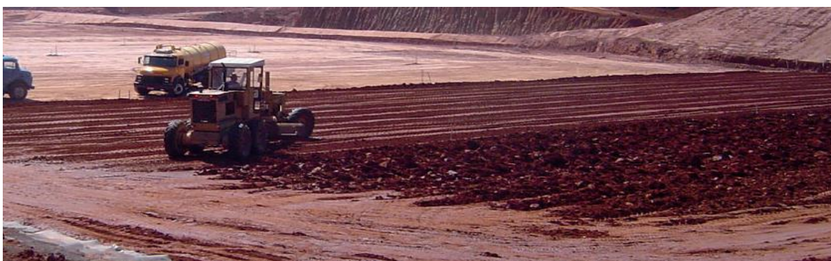
Figura 5.5 – Camada de impermeabilização da base do aterro
