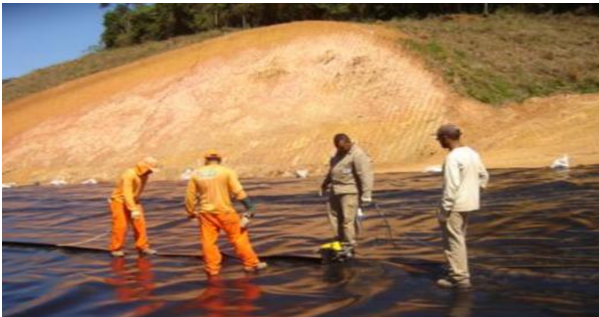
Figura 6 – Impermeabilização da camada de base
