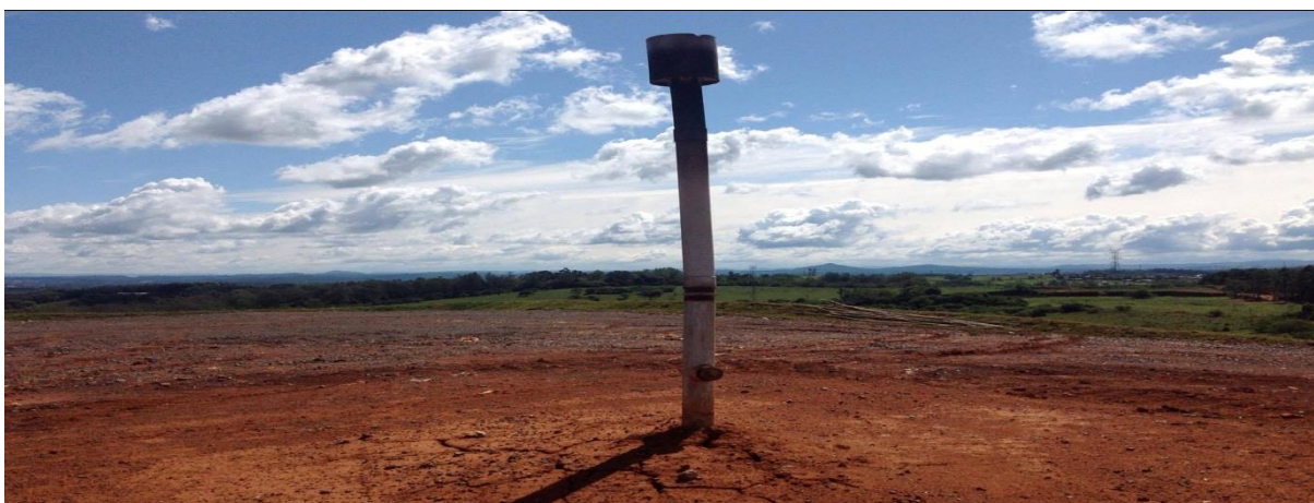
Figura 5.8 – Queimador de biogás no topo do talude
