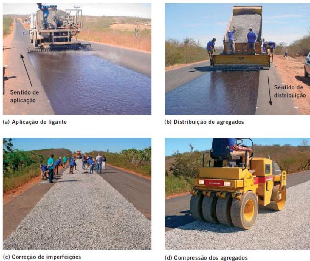
Figura 17 – Etapas construtivas de um tratamento superficial simples
