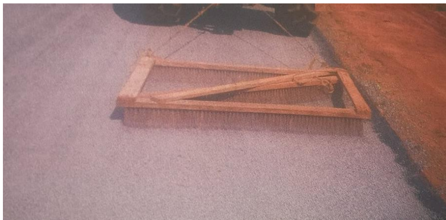
Figura 19 – Limpeza da superfície com vassoura de arrasto
