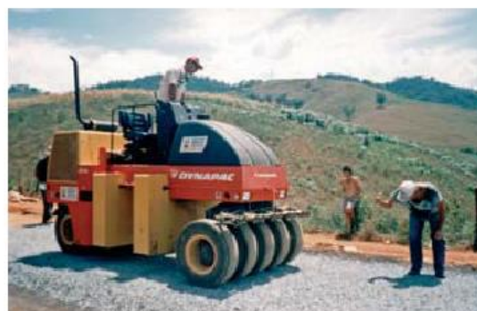
(c) Compressão dos agregados
