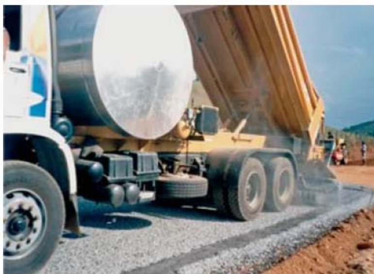
Figura 16 – Equipamento espargidor e distribuidor de agregados combinado
