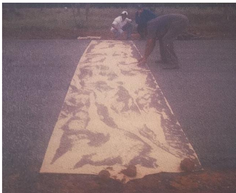
Figura 21 – Execução de juntas transversais
