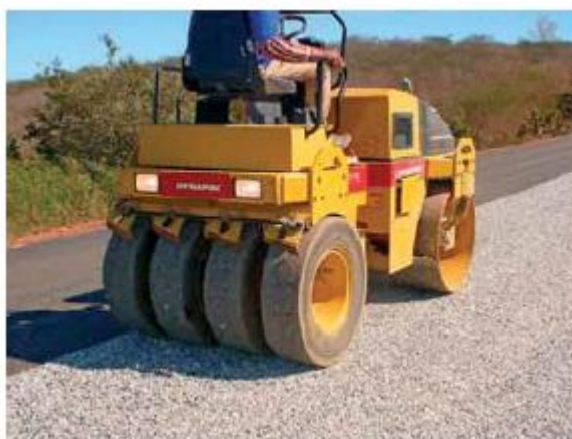
Figura 23 – Compressão dos agregados com rolo misto
