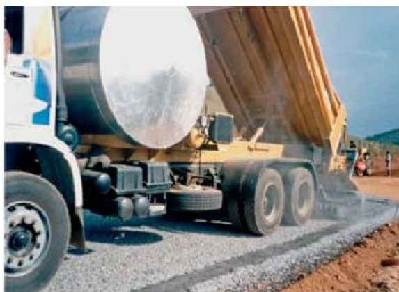
(a) Equipamento espargidor e distribuidor de agregados combinados
