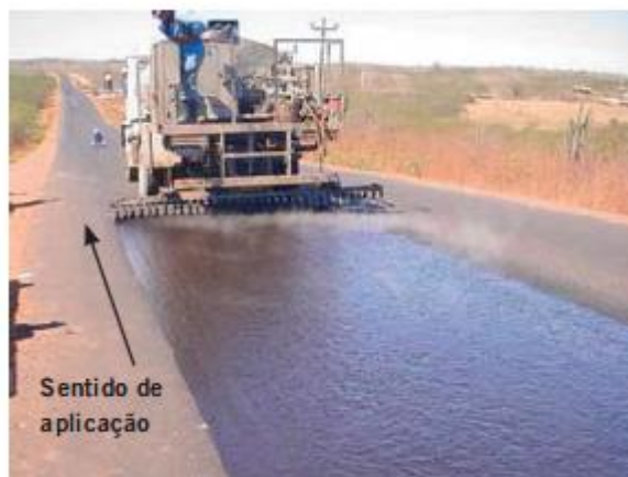
Figura 20 – Esquema de aplicação do ligante
