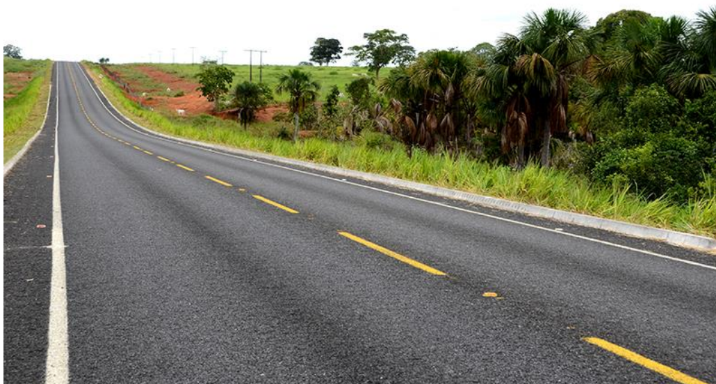
Figura 8 – Aspecto visual de rodovia com revestimento por TSD
