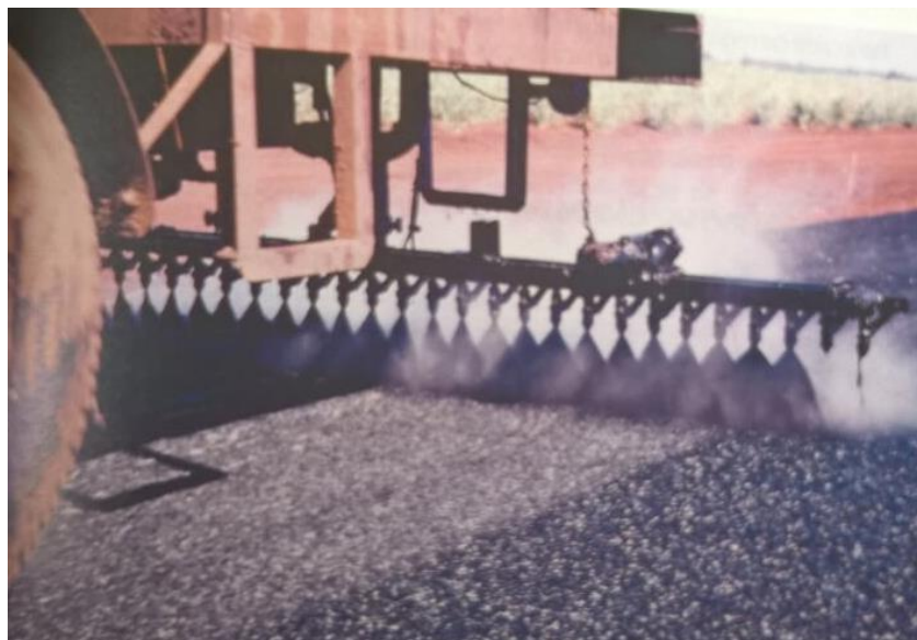
Figura 22 – Execução de juntas longitudinais
