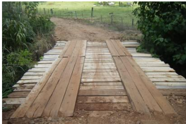
Figura 1 – Pontilhão de madeira
