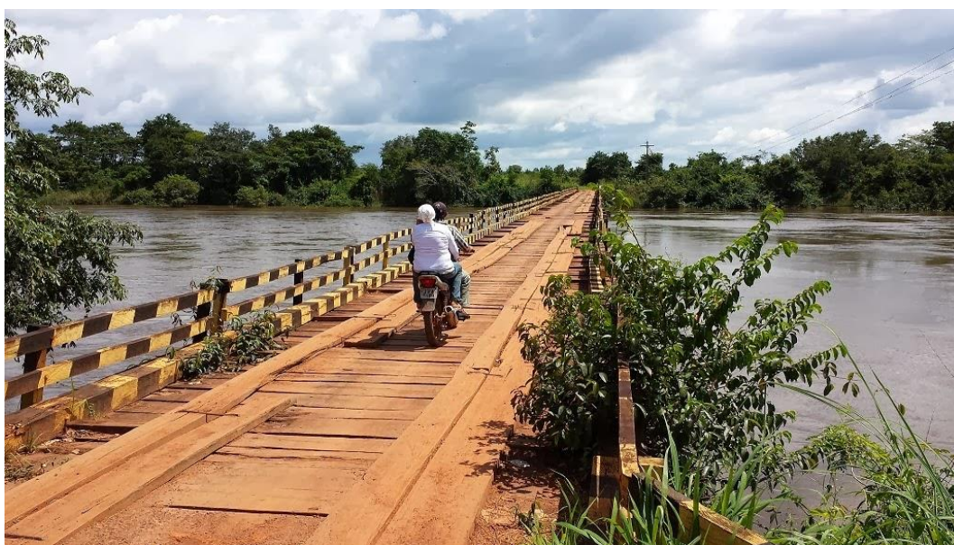
Figura 9 – Ponte de madeira sobre o Rio Pau d'Arco
