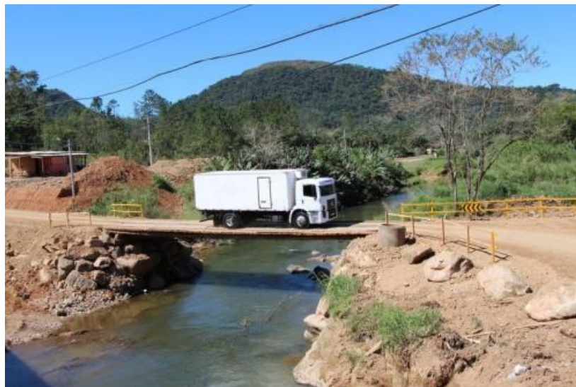
Figura 2 – Vista lateral de um pontilhão
