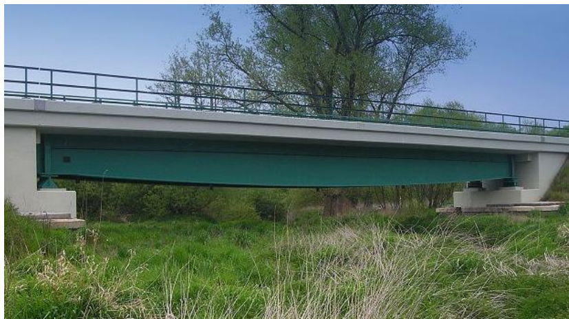
Figura 6 – Ponte em estrutura mista
