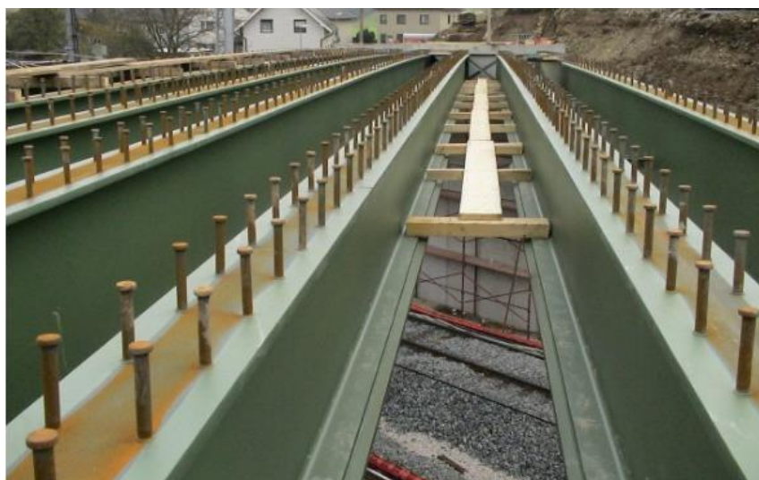
Figura 21 – Conectores stud bolt
