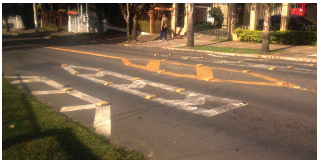
Figura 12 – Marcas de Canalização como Redutor de Velocidade na Rua Corrêa Lima
