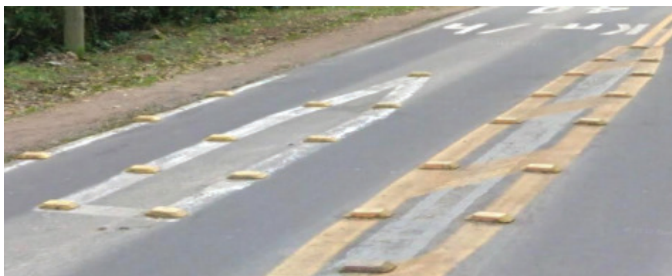
Figura 4 – Marca de Canalização como Redutor de Velocidade
