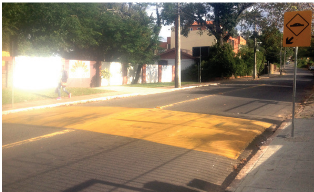
Figura 11 – Ondulações Transversais na Rua Corrêa Lima
