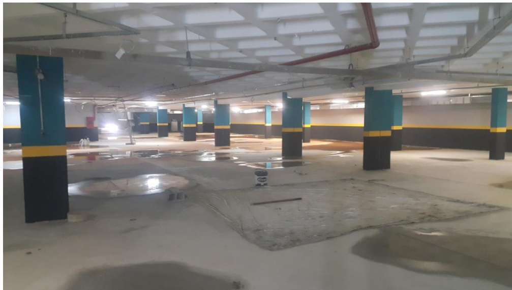
Figura 21 – Foto setor E do primeiro subsolo
