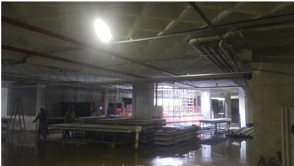
Figura 26–Área de estocagem e içamento de células de fachada
