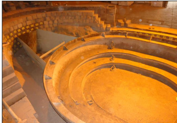
Figura 29 - Formas para acomodação da massa na carcaça do forno
