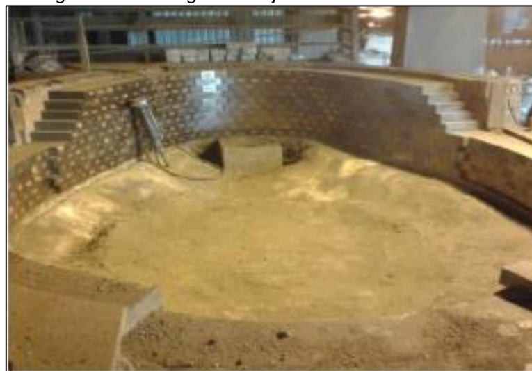
Figura 26 - Montagem dos tijolos do forno elétrico a arco
