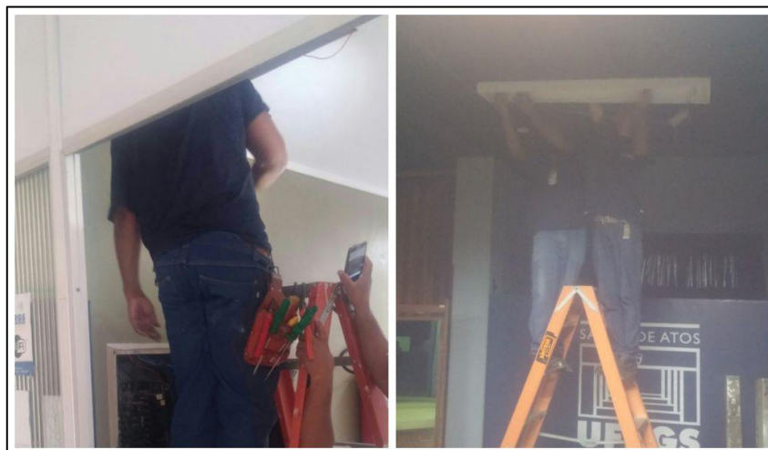
figura 15 –iluminação: improvisação ou falta
