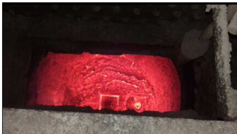
Figura 19: Abertura usada para jogar massa de reparo sobre a sede de plugue com a panela posicionada abaixo da plataforma de reparo. Fonte: (cortesia GERDAU S.A).
