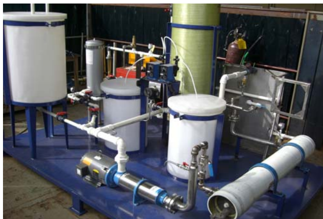
Figura 7 - Montagem das tubulações, conexões e válvulas constituintes do sistema.
