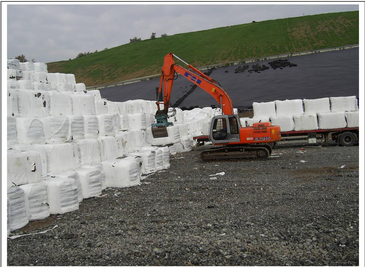
Figura 2.3 – Fardo cúbico em processo de assentamento em um aterro sanitário europeu
