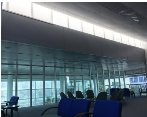
Figura 24 - Iluminação zenital lateral
