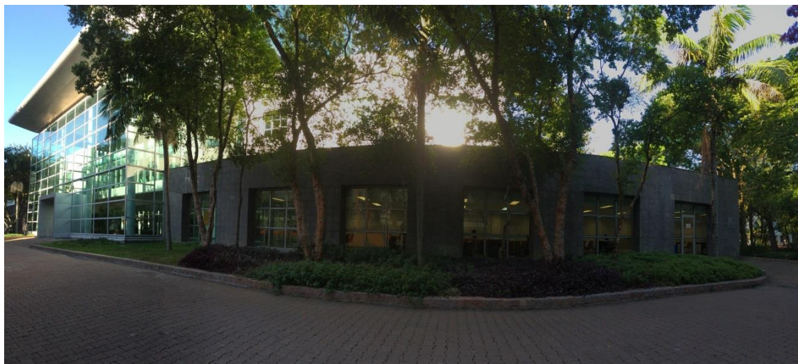
Figura 34 - Fachada oeste do pavimento térreo
