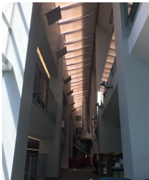
Figura 30 - Iluminação indireta com rebatedores
