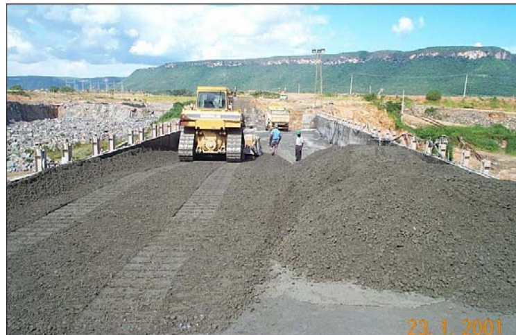
Figura 2.16 : Camada de CCR executada em rampa; UHE Lajeado - TO.
