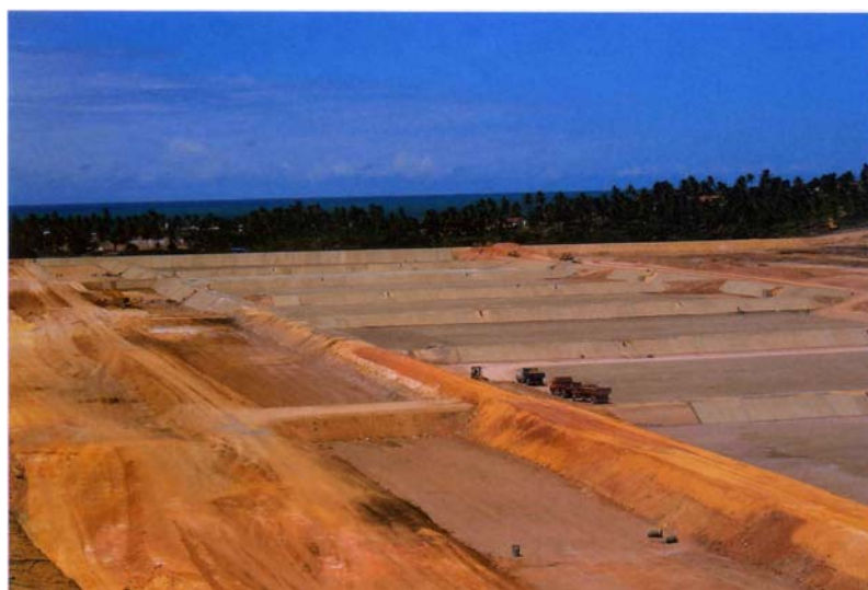
Figura 2.26 : Criadouro de camarões na Paraíba: Utiliza CCR como recurso para construção de seus viveiros (ABCP, 2005).
