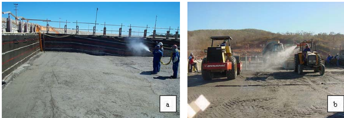
Figura 2.23 : Nebulização do CCR; (a) Processo manual: dispositivos (espingardas ou nebulizadores ligados à rede de ar e água); (b) processo mecânico: trator agrícola com nebulizador acoplado. (Foto cedida por FURNAS Centrais Elétricas S.A.).
