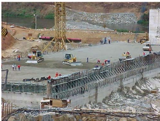
Figura 2.13 : Lançamento do CCR em camadas horizontais longas (método tradicional) – UHE Cana Brava – GO.
