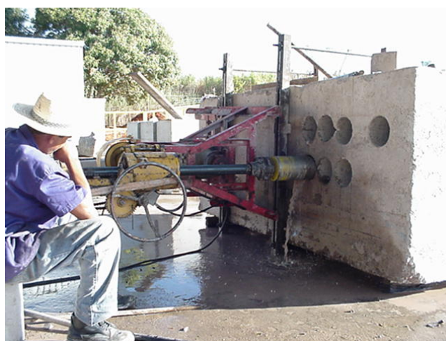
Figura 4.22 : Extração de testemunhos horizontalmente entre camadas.
