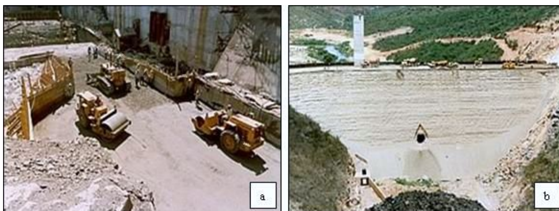
Figura 2.4 : Primeira concretagem experimental com CCR no Brasil, realizada na usina de Itaipu; (b) Primeira barragem com CCR no Brasil, realizada em Saco de Nova Olinda (MEDEIROS, 2005).
