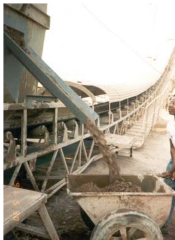
Figura 2.12 : Transporte por correia - Detalhe da Amostragem para Ensaio - AHE Peixe Angical - TO (Foto cedida por FURNAS Centrais Elétricas S.A.).
