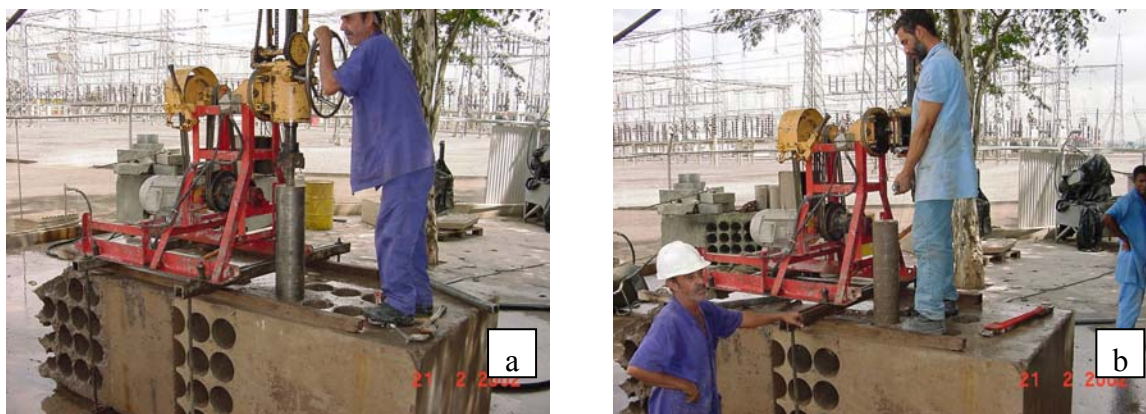
Figura 4.47 : Extração de testemunhos. (a) vista geral da extração de testemunhos; (b) retirada do testemunho extraído.
