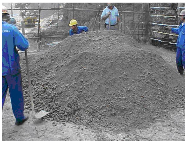
Figura 2.1 : Concreto Compactado com Rolo utilizado na construção da barragem do AHE Peixe Angical – TO (Foto cedida por FURNAS Centrais Elétricas S.A.).
