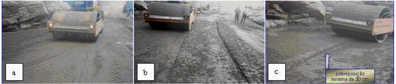
Figura 2.22 : (a) Detalhe do rolo compactador vibratório autopropelido; (b) detalhe da faixa de compactação; (c) detalhe da sobreposição das faixas numa largura mínima de 30 cm – AHE Peixe Angical – TO (Foto cedida por FURNAS Centrais Elétricas S.A.).
