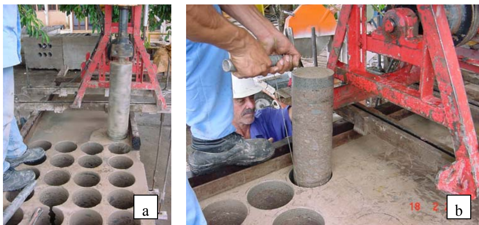
Figura 4.53 : Extração de testemunhos. (a) extração vertical; (b) detalhe da retirada do testemunho.
