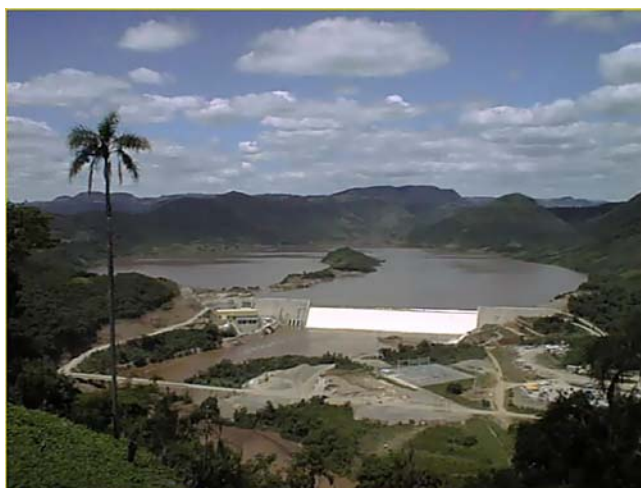
Figura 2.5 : Concreto Compactado com Rolo utilizado na construção da barragem da UHE Dona Francisca (MARQUES FILHO, 2005).
