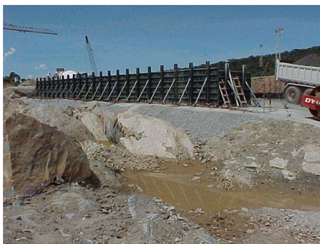
Figura 3.2 : Pista experimental em obra – UHE Cana Brava – GO.
