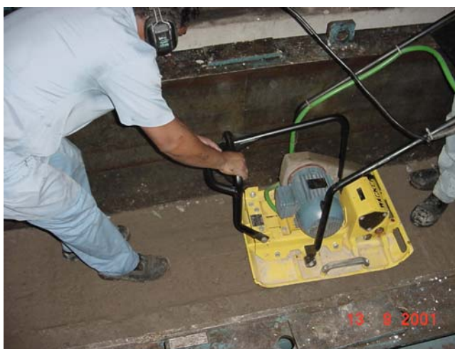
Figura 4.36 : Regularização da superfície da camada com vibro-acabadora.
