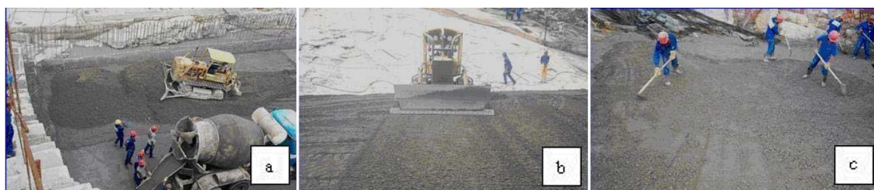
Figura 2.19 : (a) Espalhamento do CCR com trator de esteira do tipo D6; (b) nivelamento da camada com o trator de esteira operando de ré; (c) complementação do nivelamento manual da camada – AHE Peixe Angical - TO (Foto cedida por FURNAS Centrais Elétricas S.A.).
