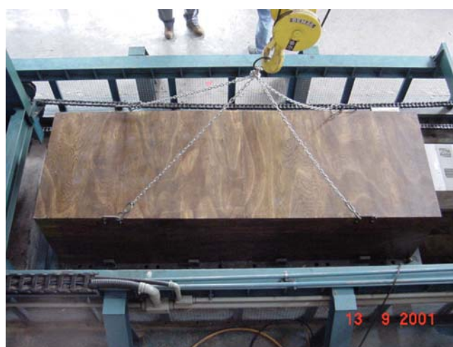
Figura 4.38 : Dispositivo de cura instalado na fôrma.
