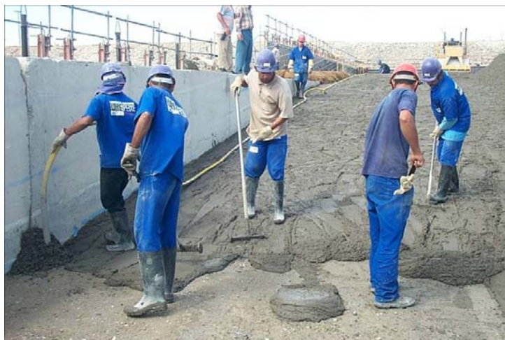
Figura 2.17 : Método rampado; Colocação da argamassa de ligação no trecho da camada rampada em contato com a camada anterior; AHE Peixe Angical - TO (Foto cedida por FURNAS Centrais Elétricas S.A)
