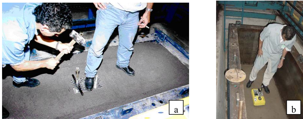
Figura 4.43 : Ensaio com Densímetro Nuclear. (a) execução do furo no maciço; (b) determinação da massa específica do CCR.
