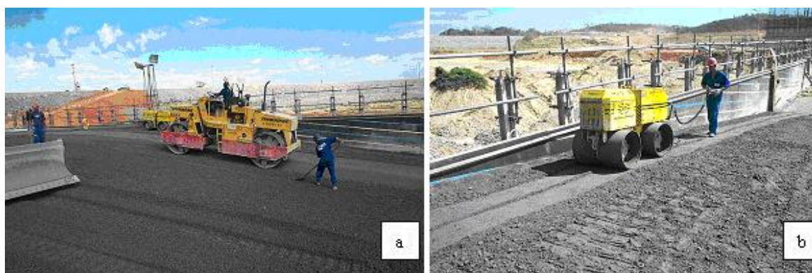
Figura 2.21 : (a) Adensamento do CCR. (b) mini rolo compactador – Compactação do CCR próximo ao paramento de montante (Foto cedida por FURNAS Centrais Elétricas S.A.).
