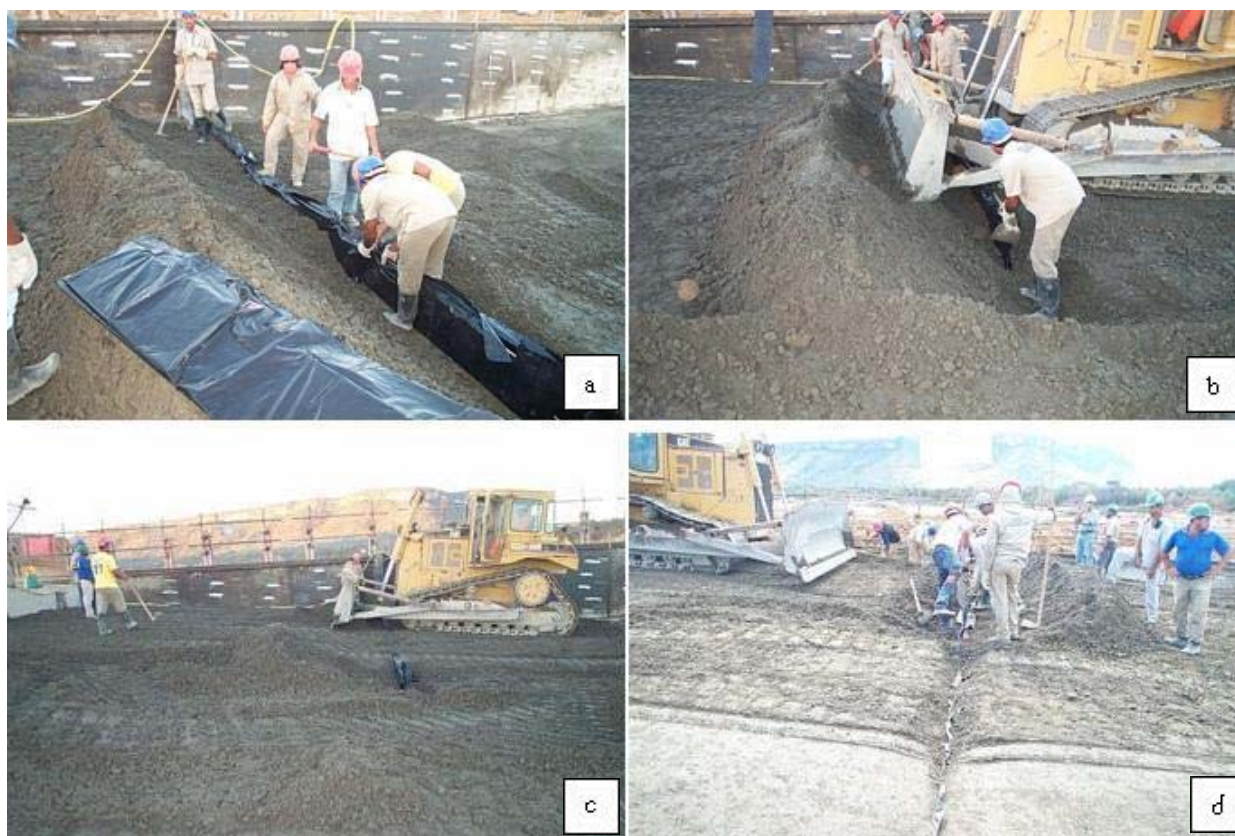
Figura 2.20 : (a) Posicionamento da junta de contração; (b) detalhe do trator cobrindo o conjunto lona / placa; (c) espalhamento de CCR na região da junta; (d) retirada da placa - UHE Lajeado – TO (Fotos cedidas por FURNAS Centrais Elétricas S.A.).
