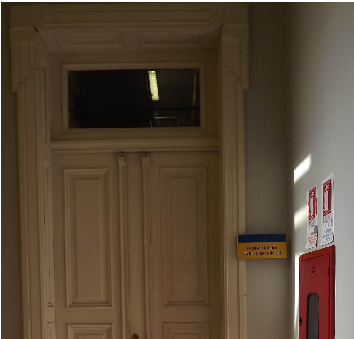
Fotografia 7 – Placa de identificação de uma porta do arquivo que não é utilizada
