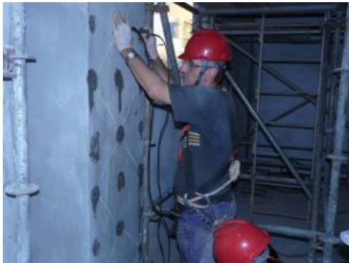
Figura 1 - Execução do Ensaio de VPU.
