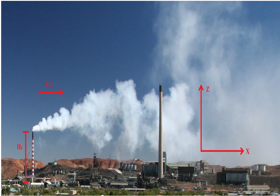
Figura 3.1: Esquema ilustrativo representando a dispersão de contaminantes para o caso bidimensional (X-Z).
