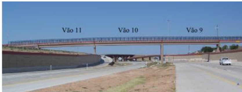
Figura 2.2 – Passarela simplesmente apoiada. [Adaptado de Zuo et al., 2012].
