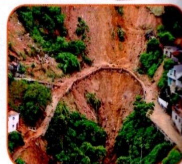
Deslizamento em encosta no município de Teresópolis, RJ (2011).
