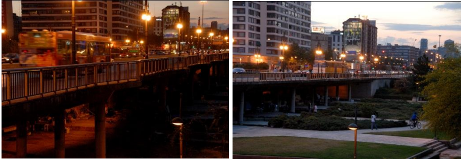
Fotos del Puente de Ademuz con la ciudad de arriba y de abajo del puente. Valencia. 2007.
