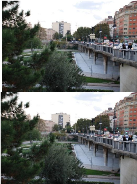
Construcción de la fuente debajo del Puente de Ademuz. Valencia. 2007.
