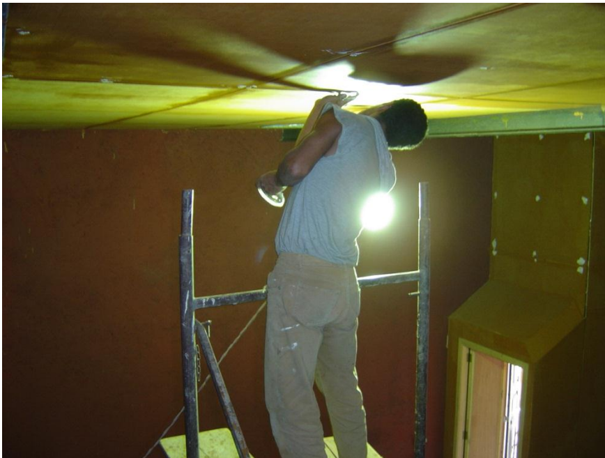
Imagen realizada por un operario trabajando en la reforma del Studio Clio . Porto Alegre. 2005.
