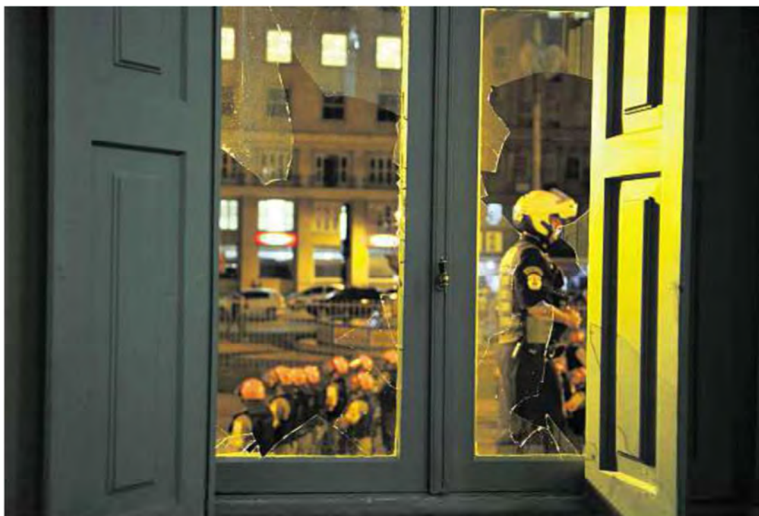
Figura 10 – Janelas da Prefeitura quebradas
