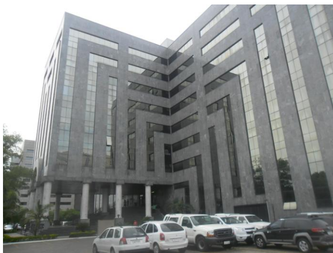
Figura 28 – Prédio-Sede da JFRS.
