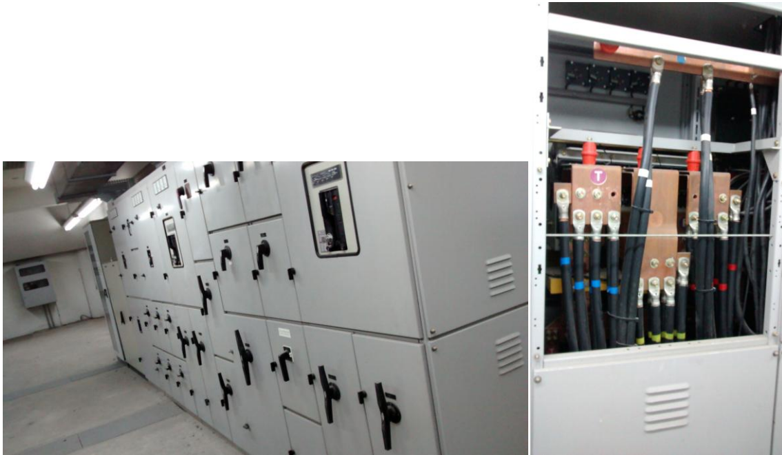
Figura 29 – QGBT de baixa tensão da subestação do prédio.
