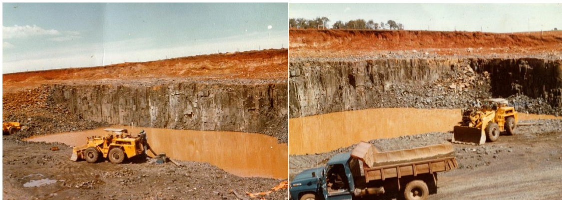
Área das pedreiras, no Rincão Gaia. Fotos de José Lutzenberger. Anos 1980 (APJL).
