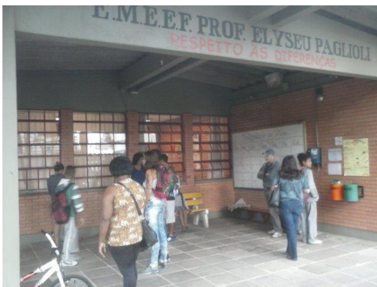
Figura 4 - Fachada da Escola Elyseu
