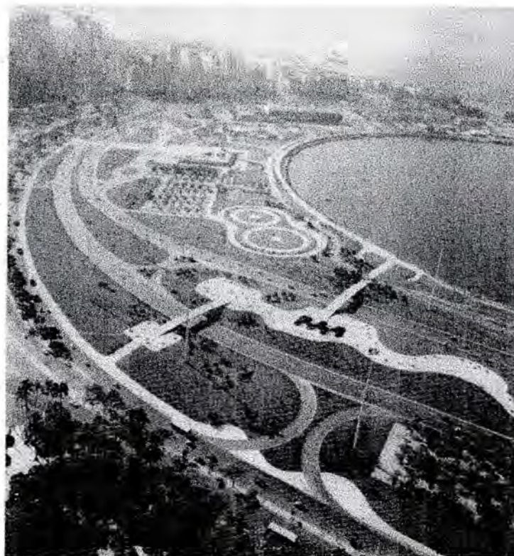
Figura 32 - Passarelas dos Pedestres Fonte: Affonso Eduardo Reidy, 1999.
