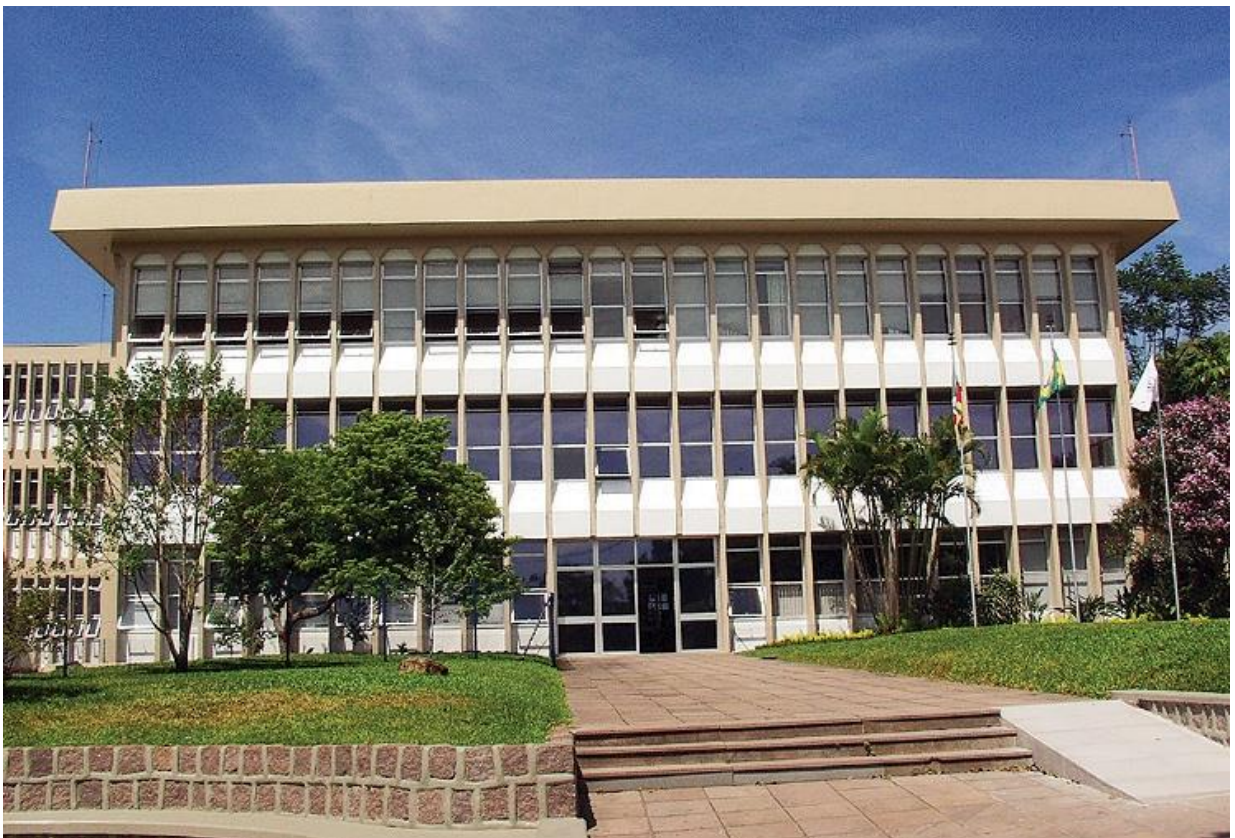
Figura 8: Fotografia da sede do colégio (Bairro Três Figueiras) Fonte: Memorial do Colégio Farroupilha
