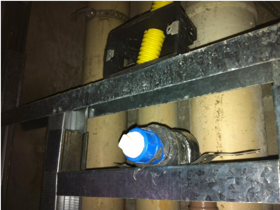
Figura 23 – Fixação dos pontos de água
