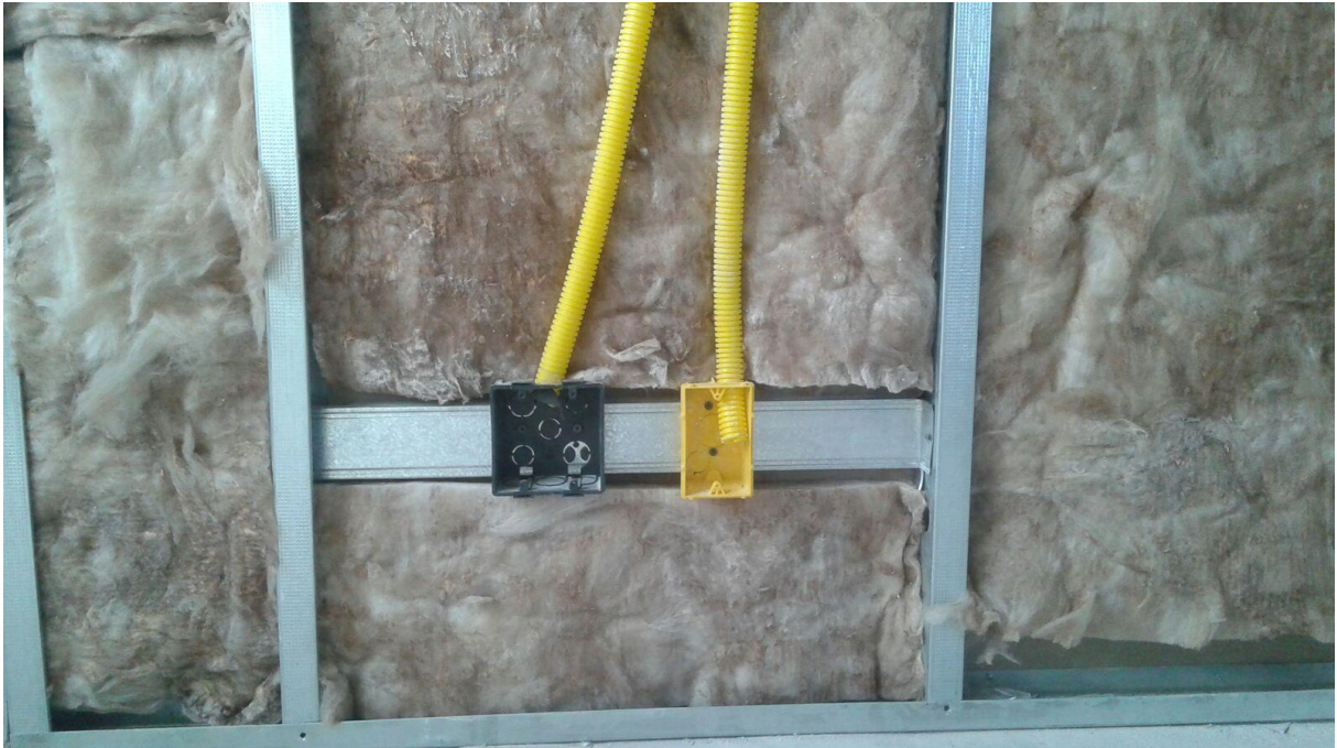
Figura 12 – Fixação das caixas de derivação
