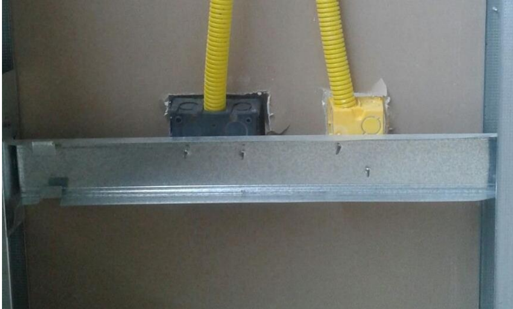
Figura 24 – Fixação das caixas elétricas
