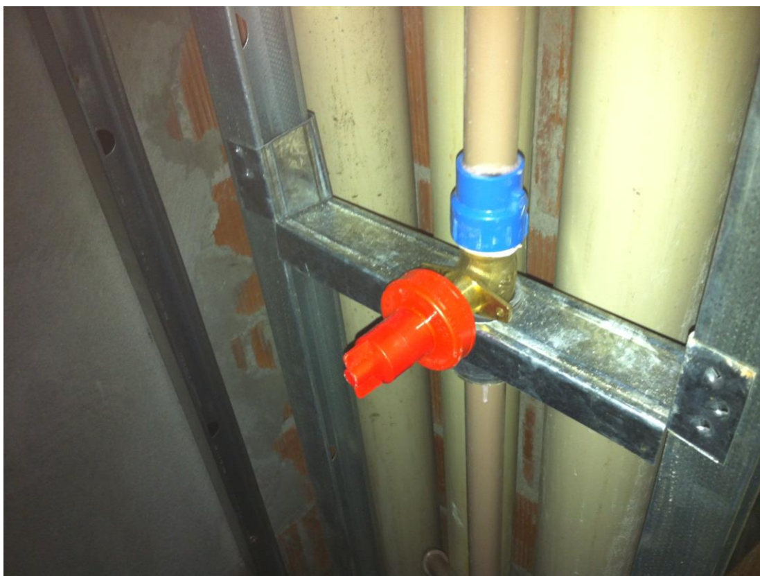
Figura 14 – Fixação de registro de chuveiro em travessa metálica
