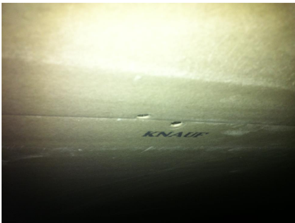
Figura 26 –Parafusos muito profundos e próximos a borda
