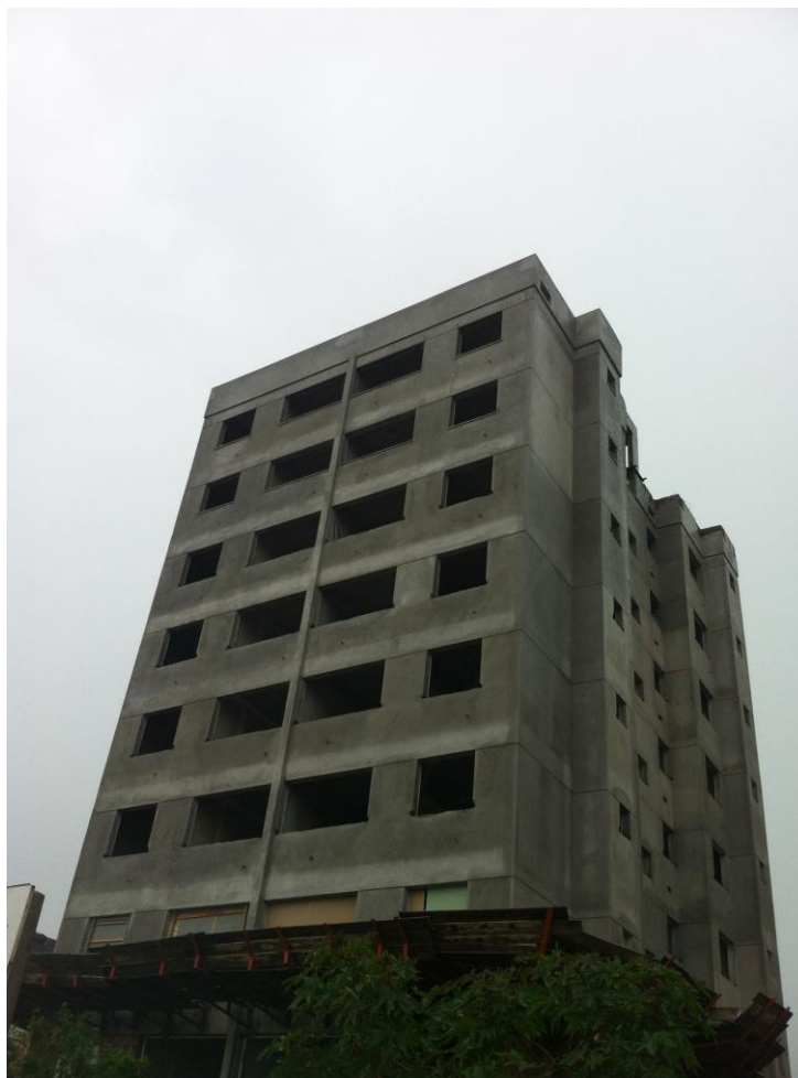
Figura 19 – Fachada do edifício estudado sem esquadrias
