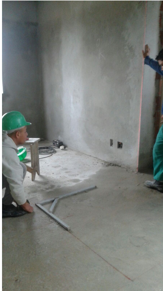
Figura 10 – Marcação das paredes
