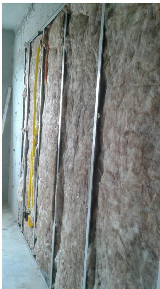
Figura 15 – Isolamento com lã mineral
