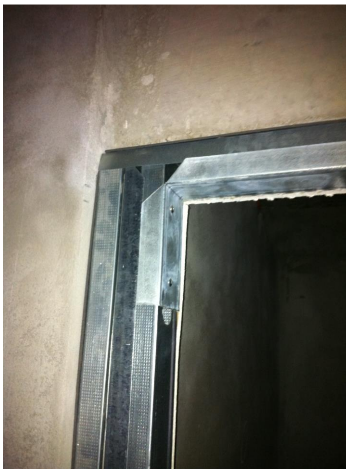
Figura 16 – Reforço superior nas portas
