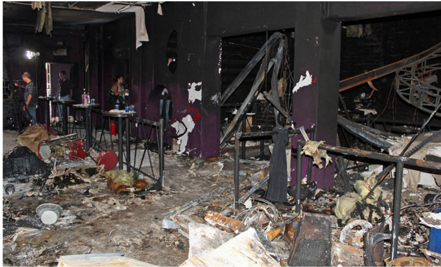
Figura 26 – Interior da boate após o incêndio
