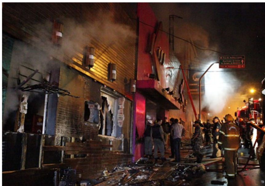
Figura 25 – Fachada da boate durante o incêndio
