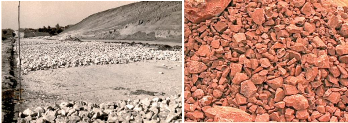
Figura 10 – Macadame hidráulico e seco
