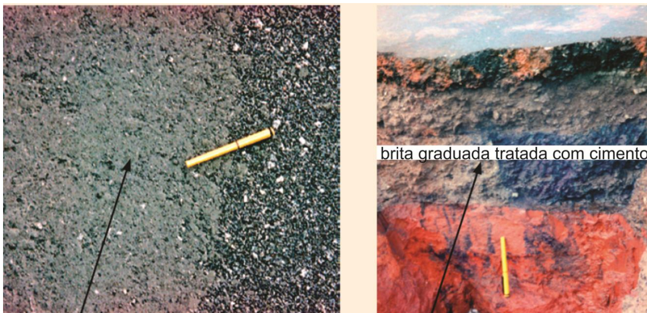
Figura 9 – Brita graduada tratada com cimento
