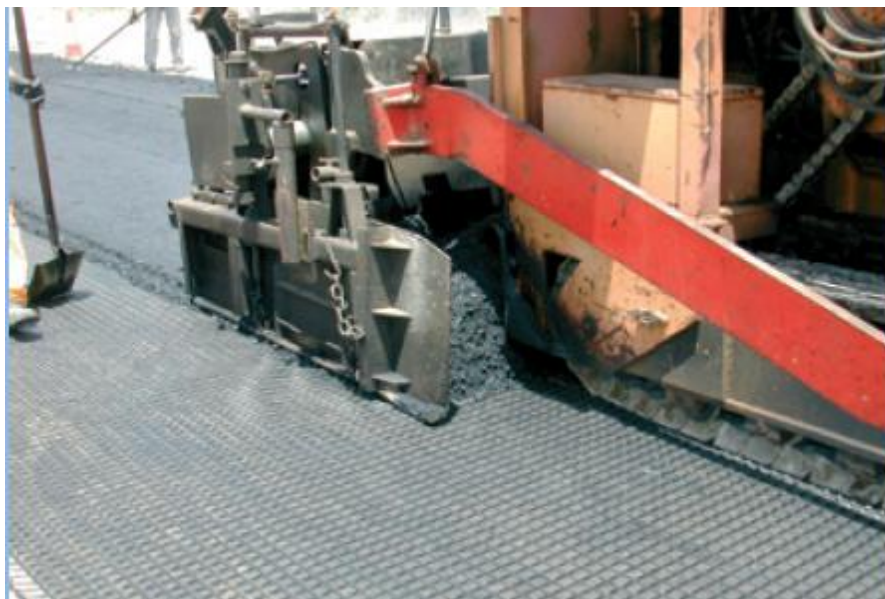
Figura 8 – Geogrelha e uma camada asfáltica sendo aplicada em cima
