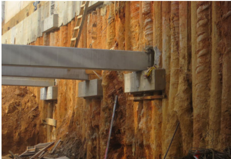
Figura 15 – Estroncamento da estrutura de contenção com chegada de vigas.
