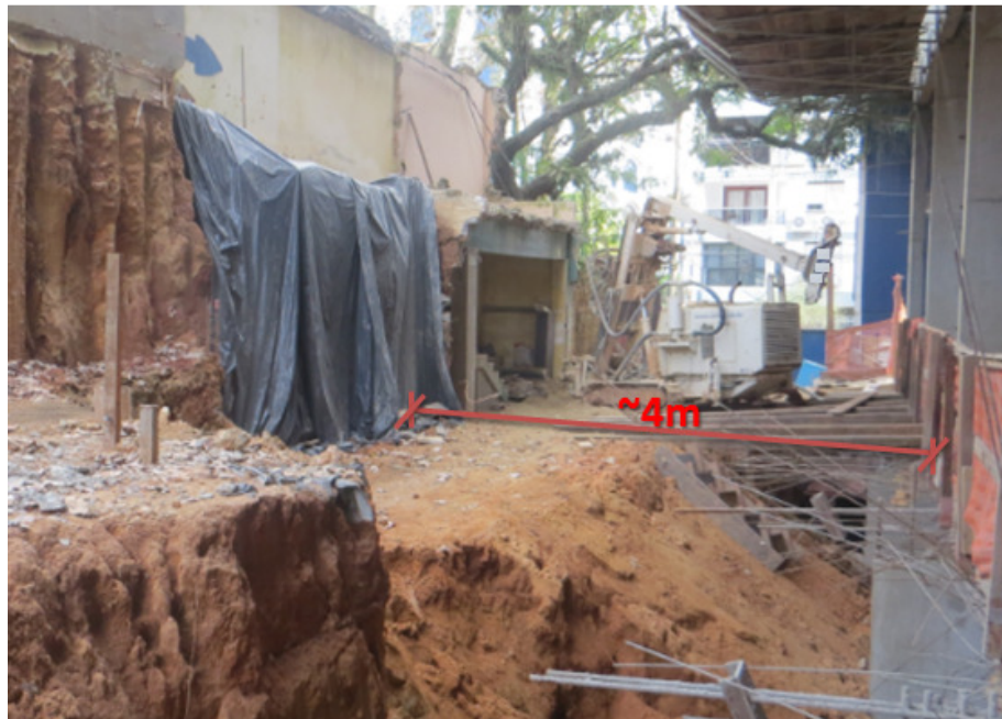
Figura 9 – Canteiro de obra com restrição de espaço
