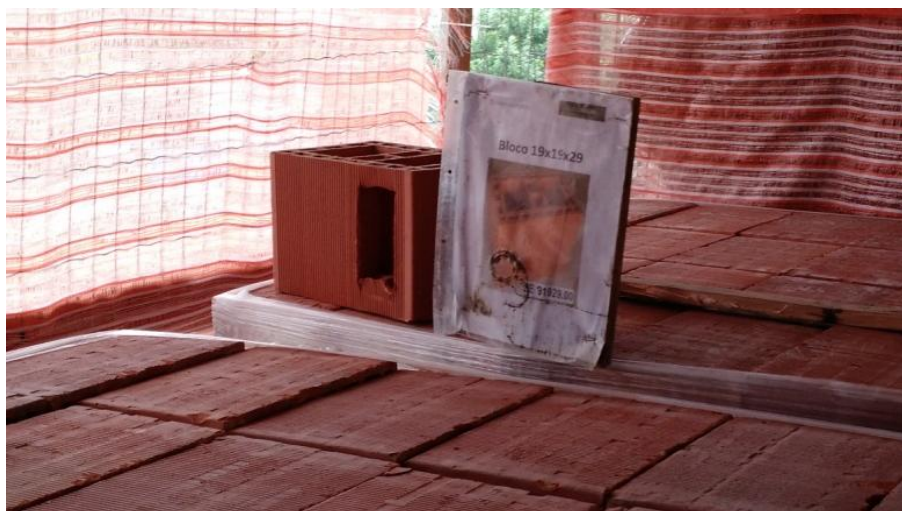
Figura 09 – Identificação dos blocos cerâmicos por foto no depósito
