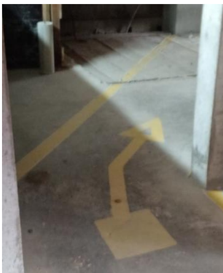
Figura 7 – Demarcação da rota de fuga no térreo das torres
