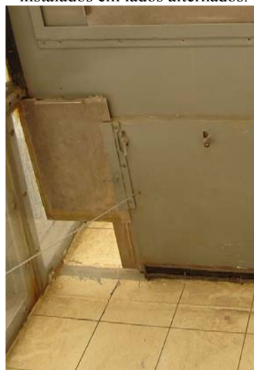
Detalhe do defletor com o orifício de fundo aberto.
