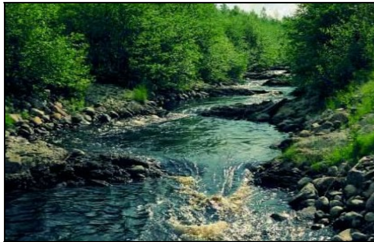
Figura 2.16 – MTP do tipo rio artificial no rio Siikajoki na Finlândia. Fonte: Larinier (2001) Foto: Marmulla.
