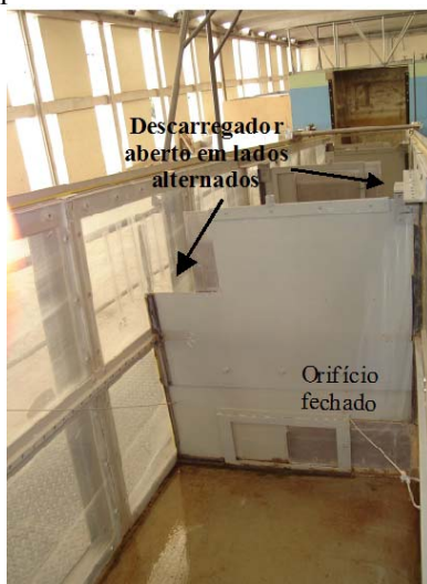
Detalhe do defletor com descarregador de superfície aberto.
