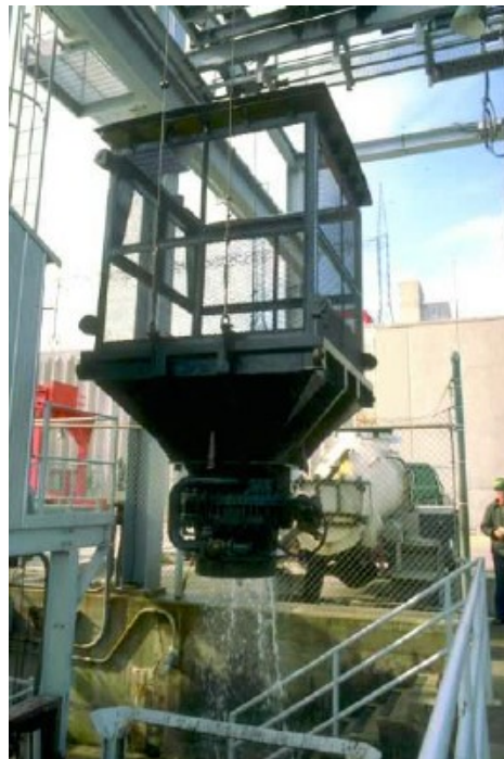
Figura 2.23 – Mecanismo de transporte de peixes instalado no Rio Saint John, Barragem Mactaquac, no Canadá. Fonte: Larinier (2001).
