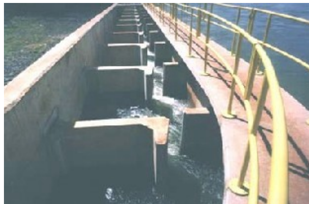
Figura A1.2 – Vista de um trecho da escada para peixes da UHE Igarapava.
