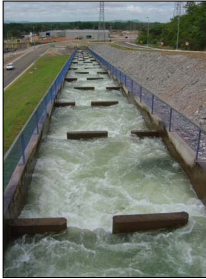
Figura 2.3 – Vista de montante para jusante da escada para peixes da UHE Peixe Angical (TO).
