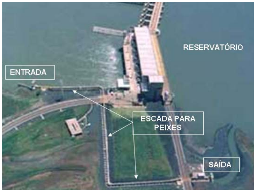
Figura A1.1 – Vista aérea da escada para peixes da UHE Igarapava. Fonte: Magalhães (2004).
