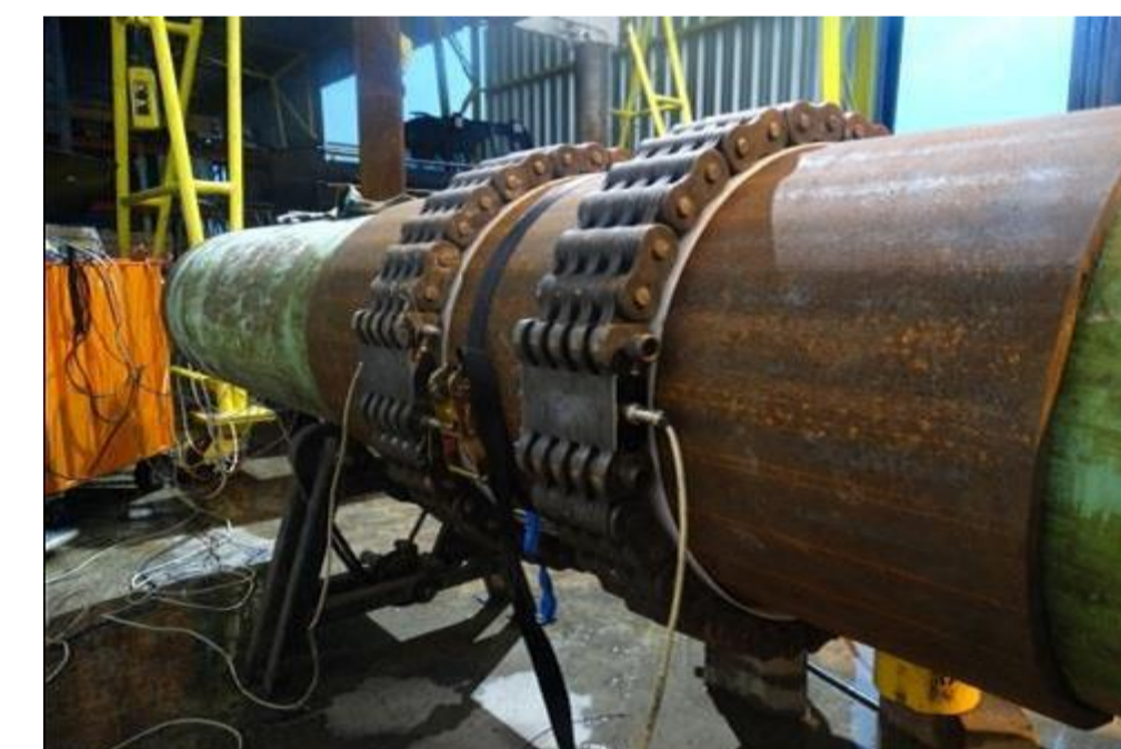
Figura 7: Transdutores de força conectados às correntes durante a aplicação do reparo tipo Dupla Calha
