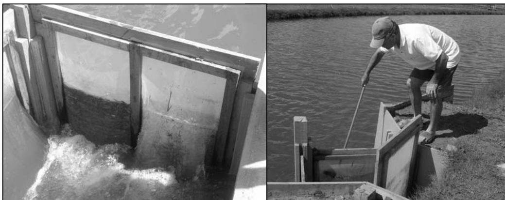
Figura 29 - Rede de contenção de animais aquáticos e plantas na entrada dos viveiros (julho de 2005).
