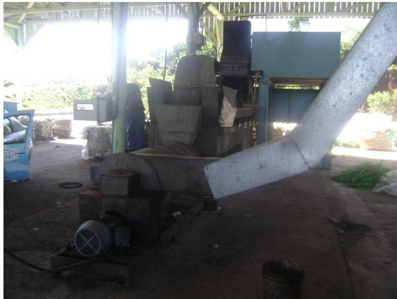
Figura 33: Antiga linha de beneficiamento em estado avançado de deterioração. Fonte: Arquivo digital CAMP.
