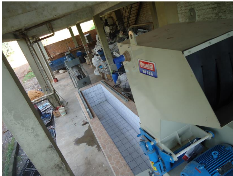
Figura 55: Moinho 400 mm de abertura para alimentação alinhado com o novo tanque de descontaminação. Fonte: Arquivo digital CAMP.
