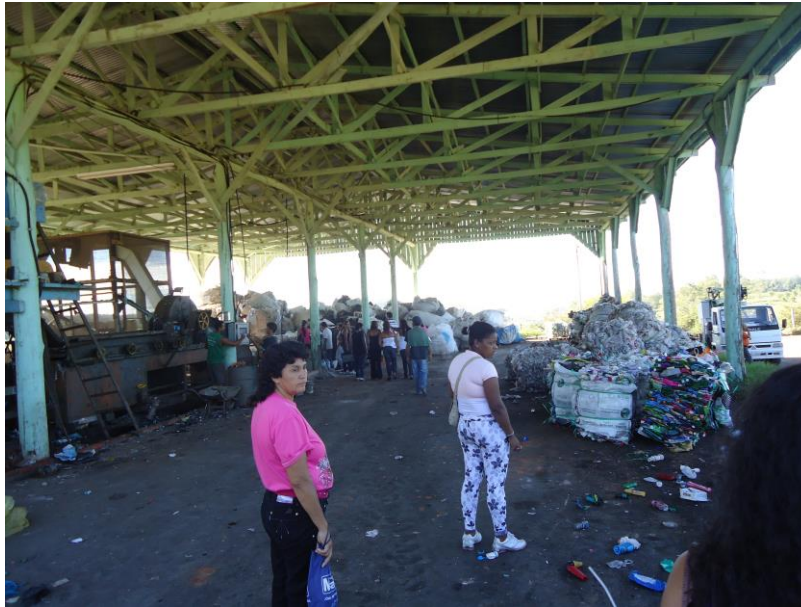
Figura 32: Local de entrada do prédio sem paredes Fonte: Arquivo digital CAMP.
