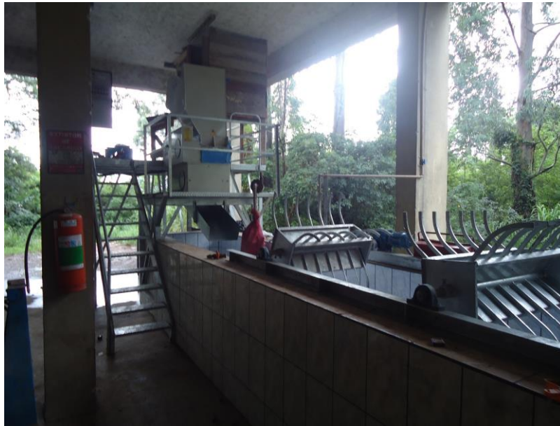
Figura 60: Plataforma, moinho e equipamento de arraste aranha instalados. Fonte: Arquivo digital CAMP.
