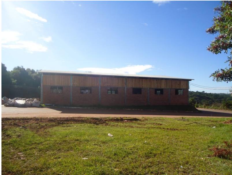
Figura 35: Obra concluída de fechamento do galpão Fonte: Arquivo digital CAMP
