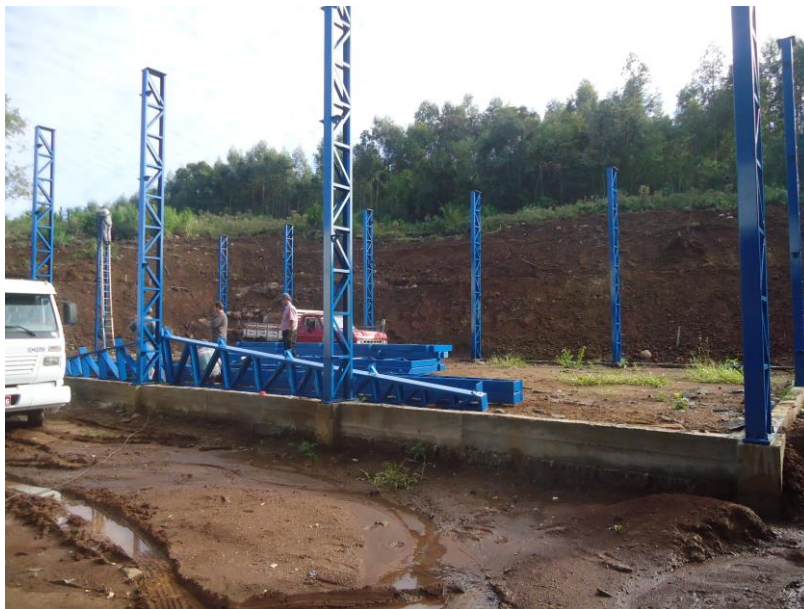
Figura 52: Início da obra para área de estocagem de fardos. Fonte: Arquivo digital CAMP.
