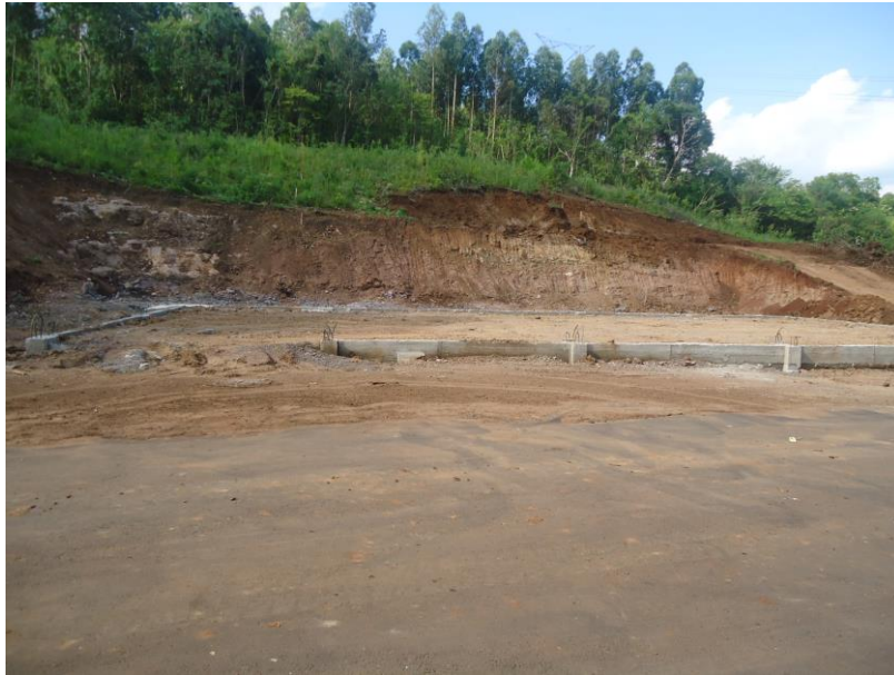
Figura 51: Área destinada à construção da área de estocagem de fardos Fonte: Arquivo digital CAMP.
