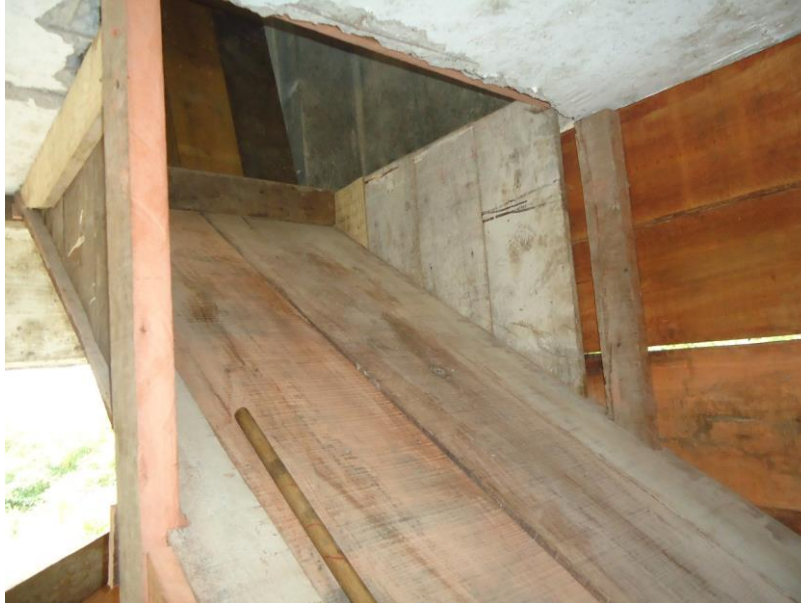
Figura 56: Acesso do estoque (andar superior) ao novo moinho. Fonte: Arquivo digital CAMP.
