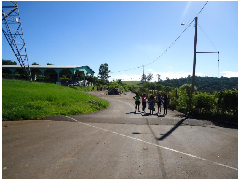
Figura 31: Prédio onde se localiza o beneficiamento sem paredes (ao fundo) Fonte: Arquivo digital CAMP
