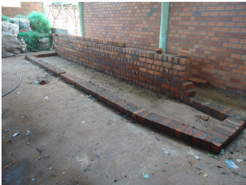
Figura 36: Construção do tanque para a lavagem de plásticos Fonte: Arquivo digital CAMP
