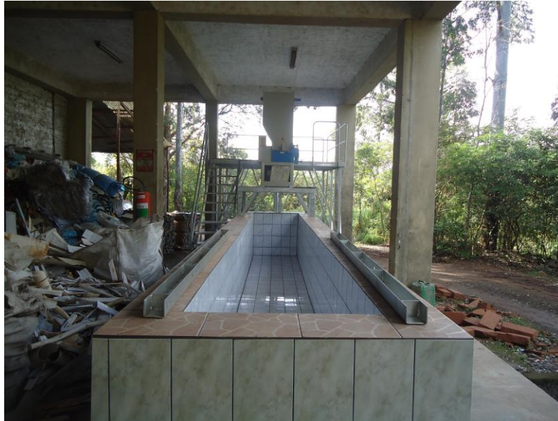
Figura 54: Novo tanque de descontaminação construído Fonte: Arquivo digital CAMP.
