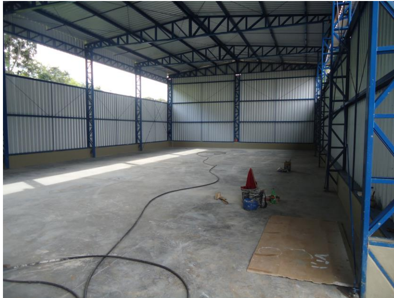
Figura 53: Área de estocagem de fardos concluída.
