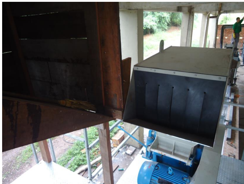
Figura 57: Acesso do estoque (andar superior) ao novo moinho. Fonte: Arquivo digital CAMP.
