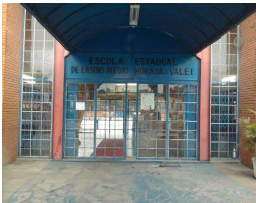
Figura 1: Vista frontal da entrada da escola CIEP
