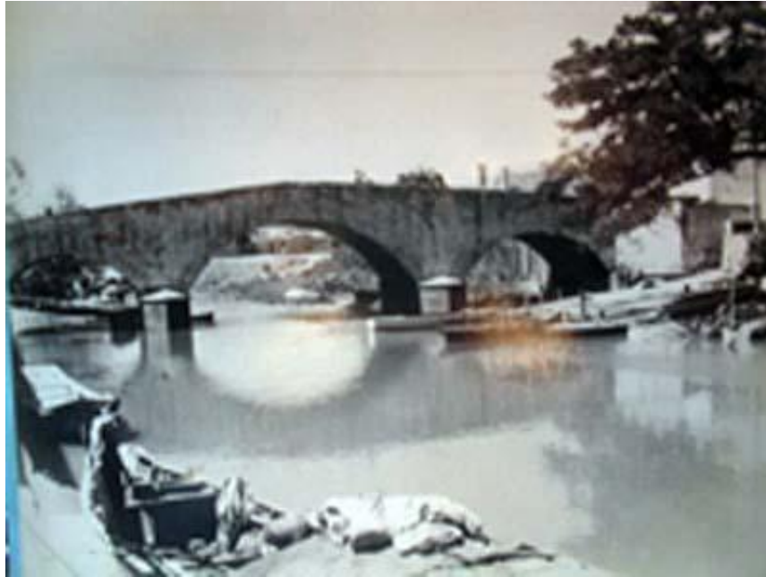
Imagem 40 - Ponte de Pedra Centro/Cidade Baixa.
