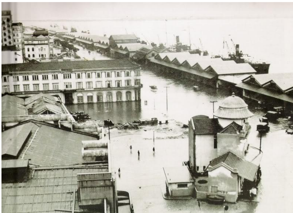
Imagem 33 - Enchente de 1941, Avenida Mauá, Centro.
