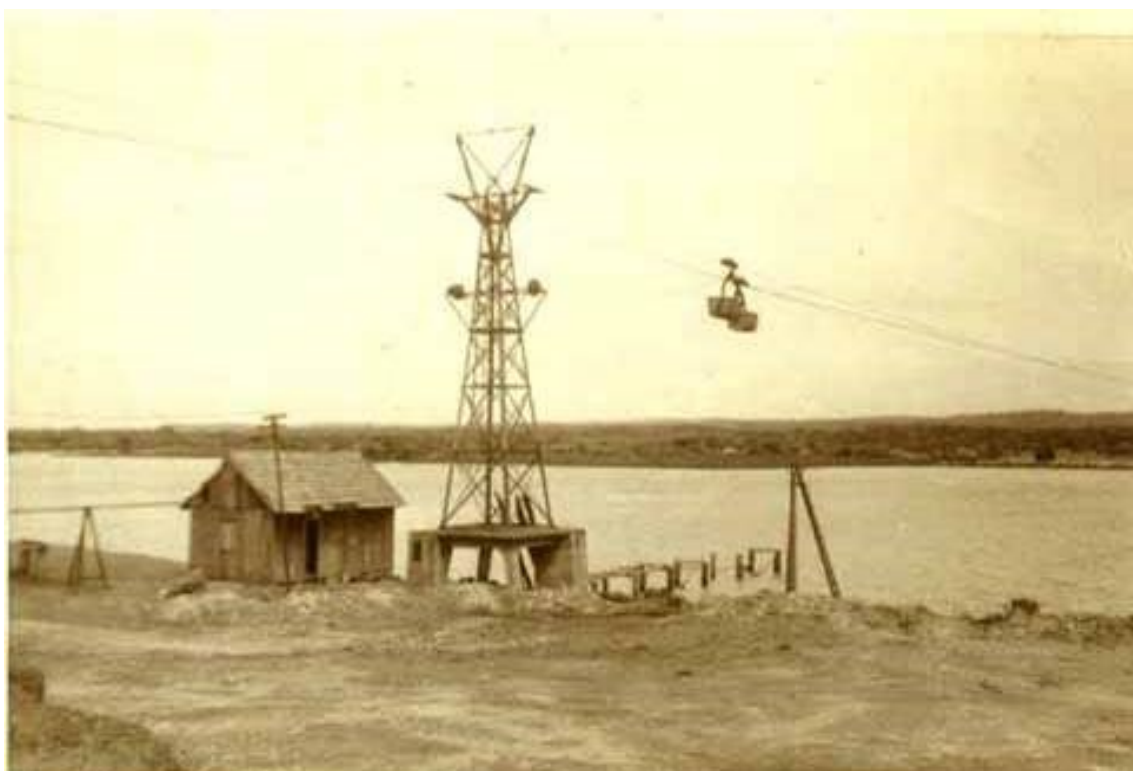
IMAGEM 10. O cabo atravessando o Rio Jacuí.
