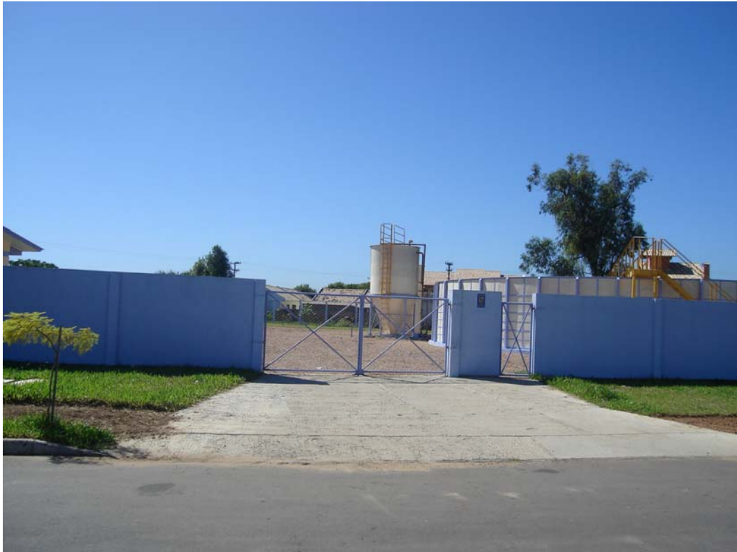
Figura 33 - Estação de tratamento de esgotos - ETE Fonte: Nanci, 10 de abril de 2007
